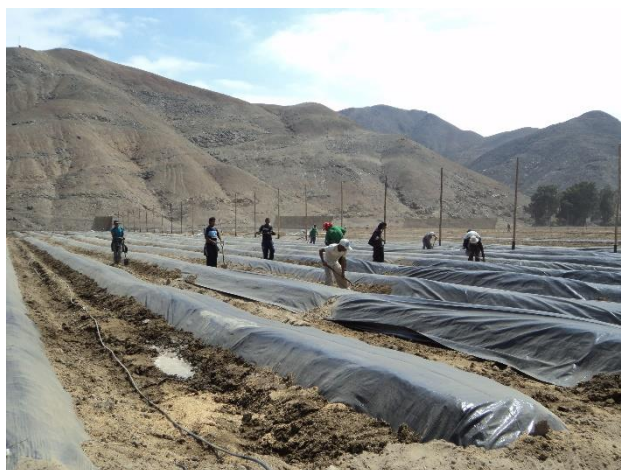
Figura 9. Instalación de manta cubresuelos.
