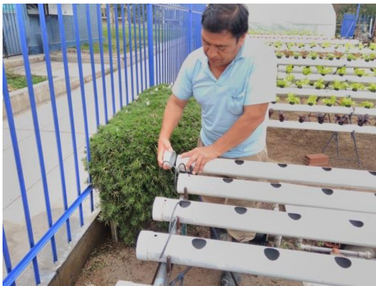
Figura 19: Técnico terminando de armar el sistema NFT después de su lavado de mantenimiento
