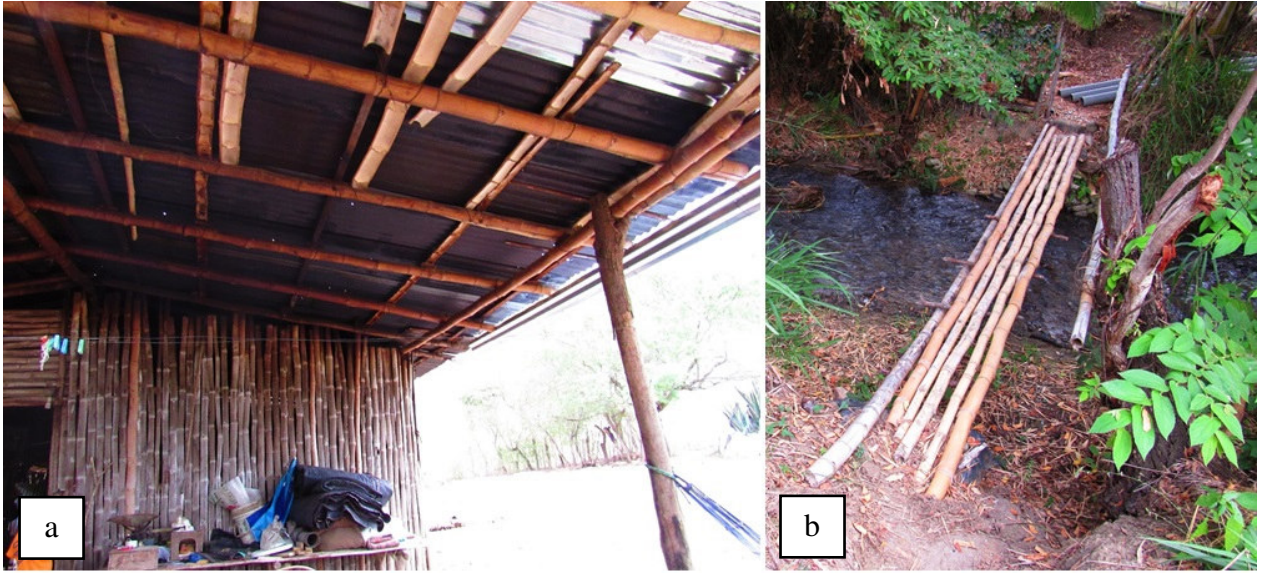
a) Culmos utilizado en pared y techo de cabaña, y b) Puente artesanal con culmos.
