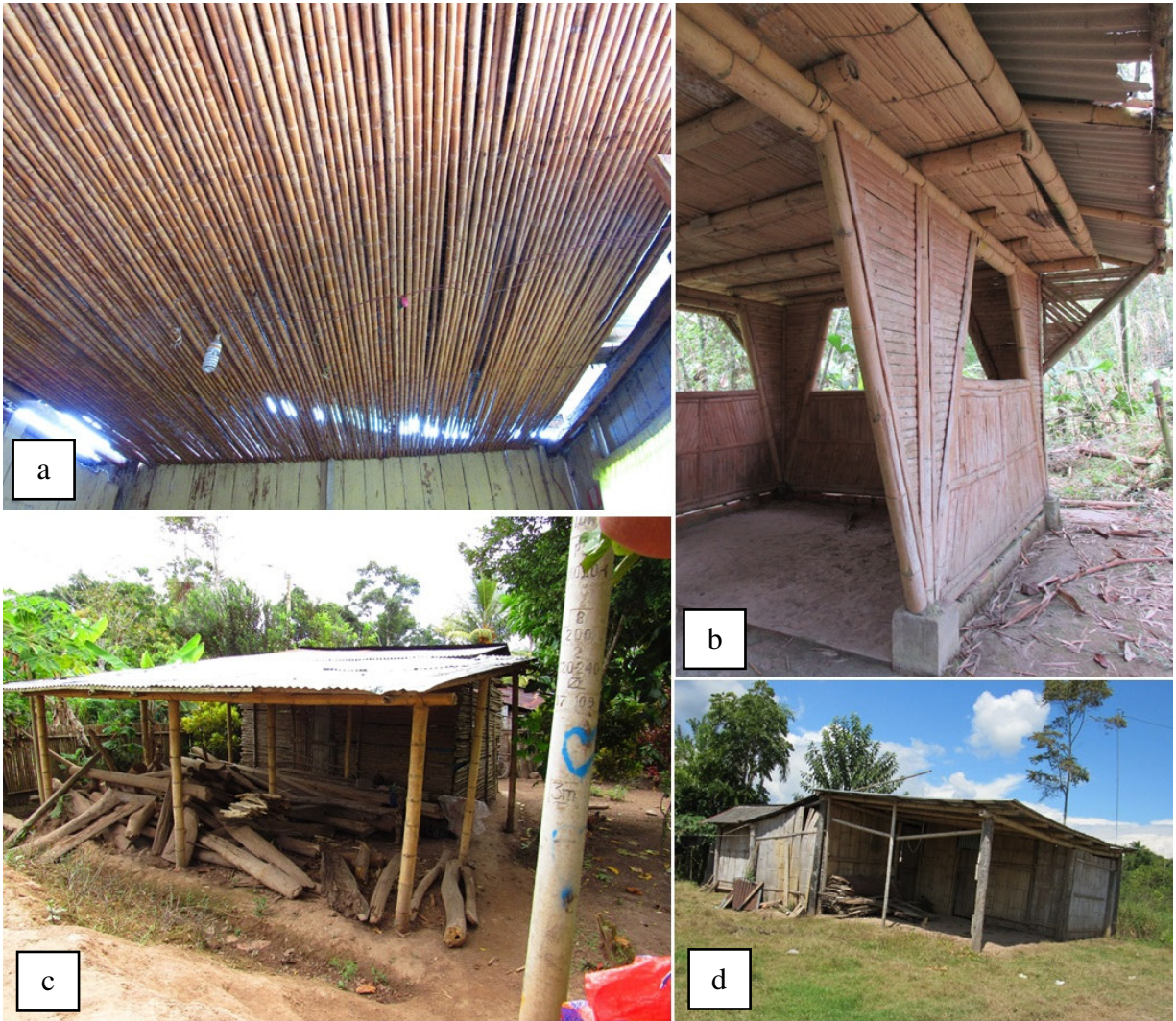
a) Techo interior de vivienda, b) Cabaña de marona construida en el bosque el maronal, c y d) Cabañas construidas con culmos.
