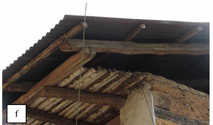
a, b) Culmos utilizados como vigas y viguetas en techo, c, d) Culmos utilizados como cerco y puerta, e, f) Culmos combinados con barro para el techo de una casa.
