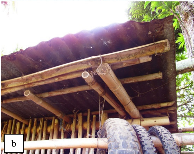
a) Choza construida con culmos, b) Culmos utilizados en pared y techo de cabaña, y c) Escalera artesanal con culmos.
