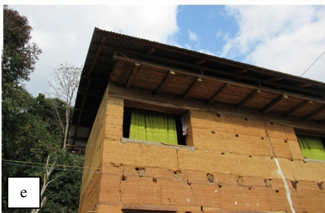
a, b) Culmos utilizados como vigas y viguetas en techo, c, d) Culmos utilizados como cerco y puerta, e, f) Culmos combinados con barro para el techo de una casa.
