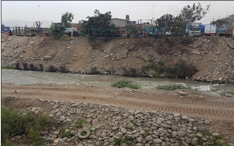
**Foto 4.** Vista del dique existente sobre de la margen izquierda del cauce del río (a la altura de la progresiva 0+300), el ancho promedio de la corona en éste tramo es de 25 m.
