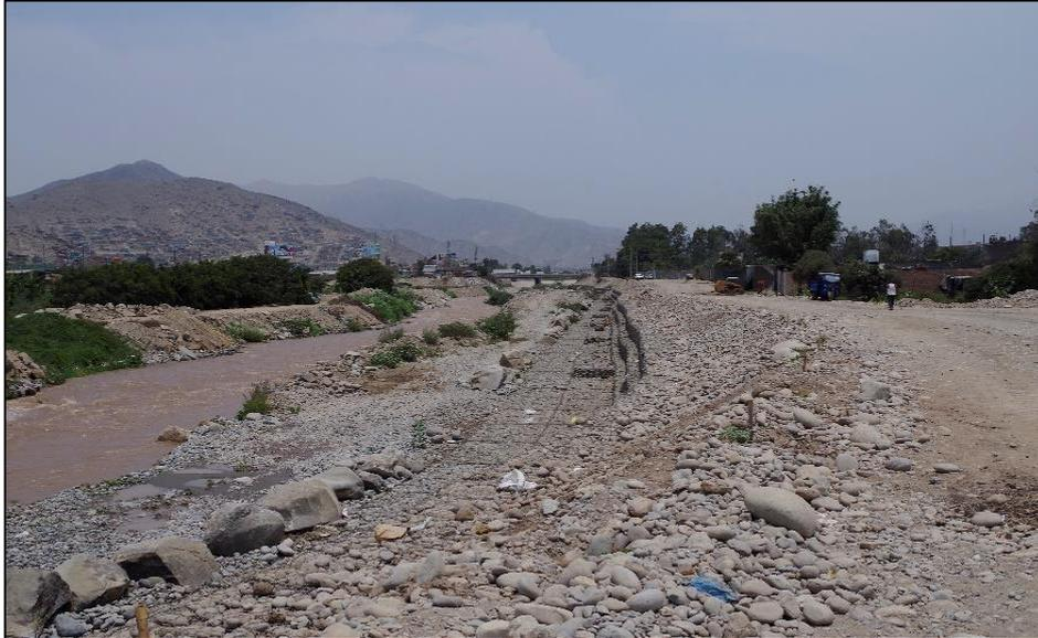
**Foto 6.** Hacia aguas abajo (Progresiva 0+500), se evidencia que el cauce se encuentra con un trazo definido, la presencia de material de arrastre ha sido restringido hacia las márgenes del río dejando una sección de conducción libre de obstáculos.
