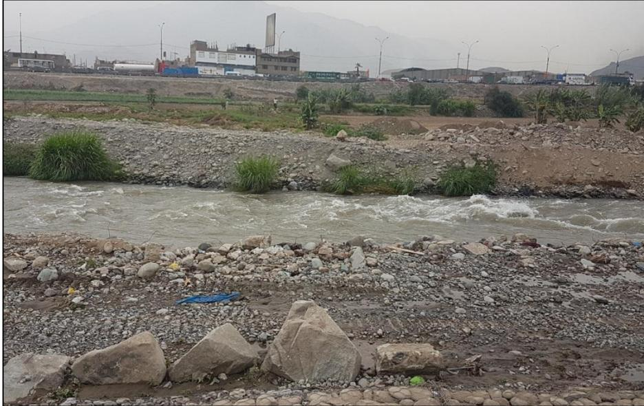
**Foto 8.** Vista del dique existente sobre de la margen derecha del cauce del río (Progresiva 0+550), se nota que éste se encuentra consolidado y el ancho promedio del dique en este tramo es de 15m. Además de la ubicación de hitos de faja marginal colocados el año 2015.
