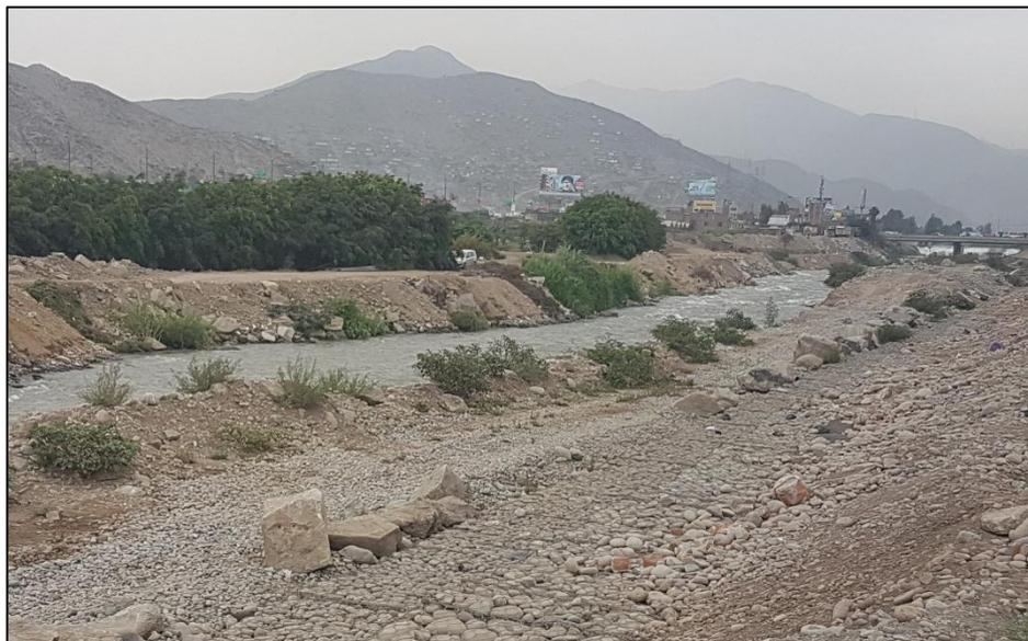
**Foto 5.** Vista del cauce hacia aguas arriba (Progresiva 0+350), se observa que el cauce se encuentra sin mayor presencia de acumulación de sedimentos, pero en el margen izquierdo tiene presencia de vegetación, la cual consolida la estabilidad del dique.
