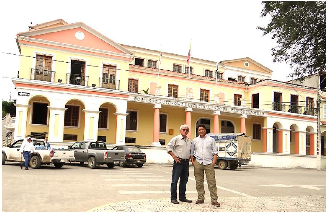
Foto 5: Edificio del Gobierno Autónomo Descentralizado del Cantón Zapotillo
