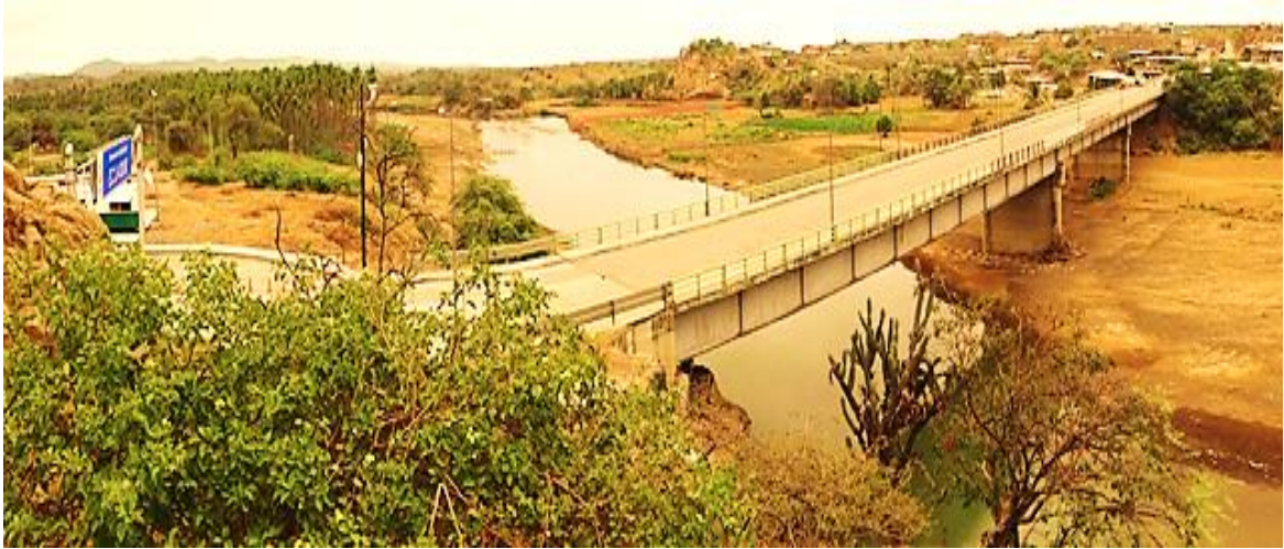
Foto 13: Puente internacional Ecuador – Perú, barrio Lalamor, río Alamor
