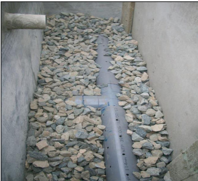
Anexo 1.3: Llenado del filtro en la zona de salida del humedal.
