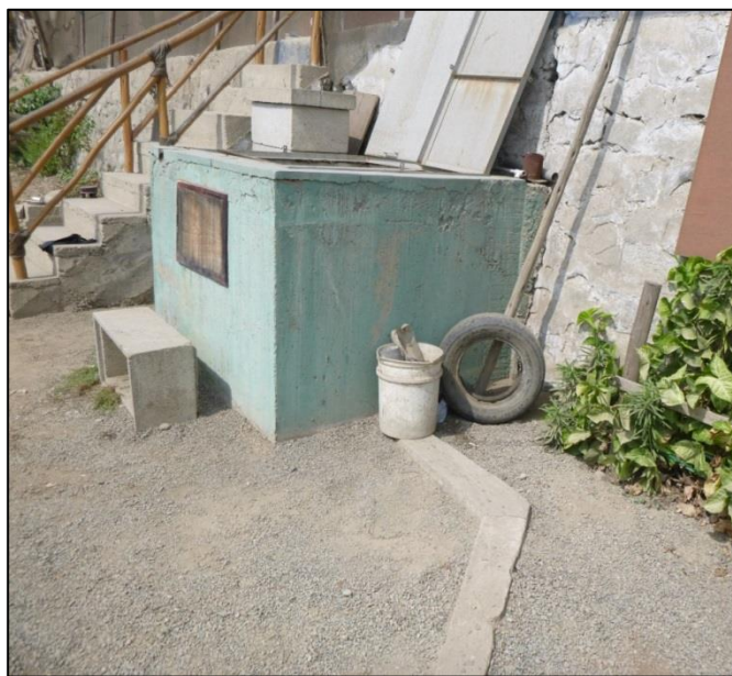
Anexo 1.6: Vista exterior de la trampa de grasa.
