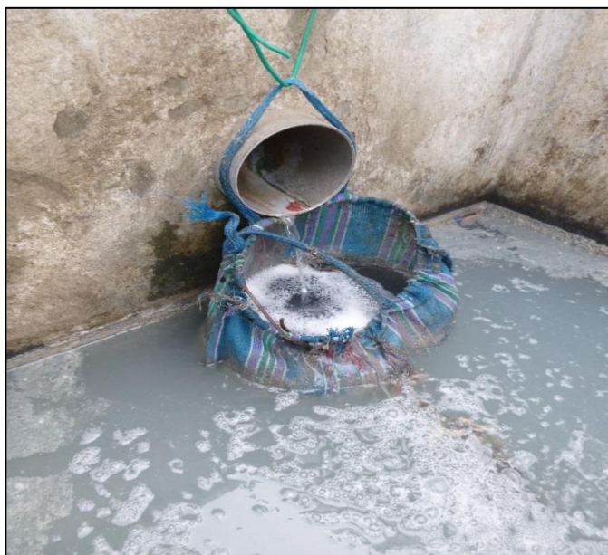
Anexo 1.8: Malla de plástico usada como rejilla para retener solidos gruesos.
