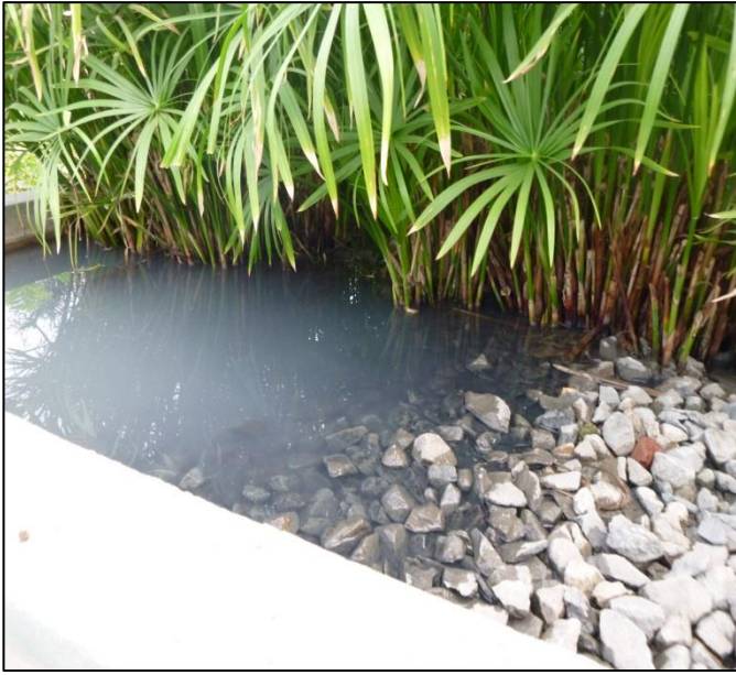
Anexo 1.44: Colmatación en la zona de entrada del humedal.
