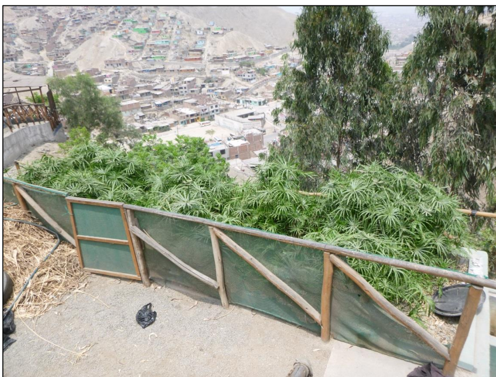
Anexo 1.10: Vista del humedal artificial subsuperficial de flujo horizontal
