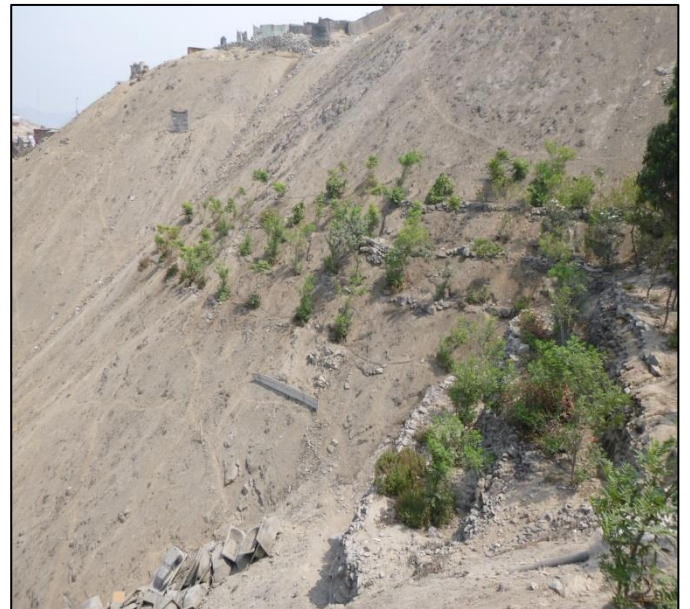
Anexo 1.43: Ampliación de las áreas verdes como medida de protección y prevención de derrumbes.
