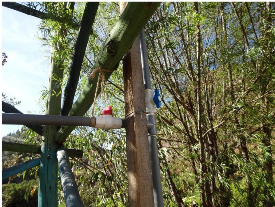
**Foto 4: Válvulas de bola para modificar la altura de bombeo.**
