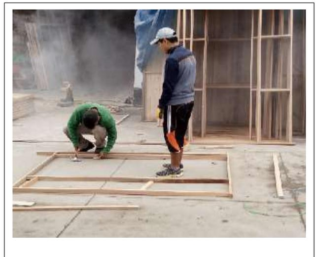
**Foto N° 2.** Armado de entramado de muros.
