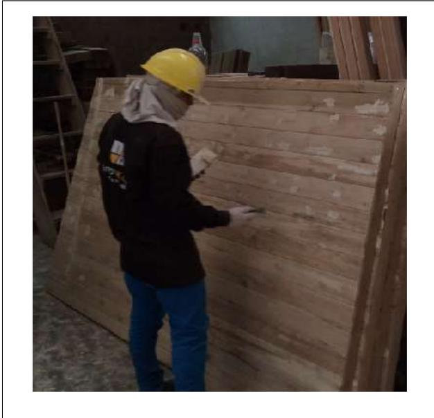
**Foto N° 3.** Masillado de paredes machimbradas.
