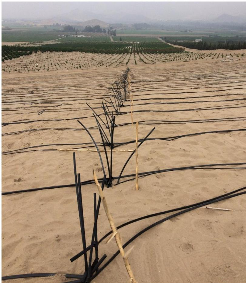
**Imagen No 25: arranques de manguera de 16mm**
