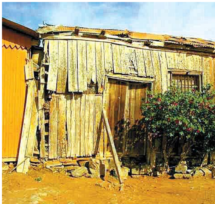
Figura 6: Vivienda dañada por el ataque de Cryptotermes brevis .
