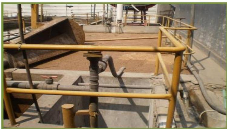
**Figura N°14: Sistema DAF y cuchara de recolección de lodos.**
