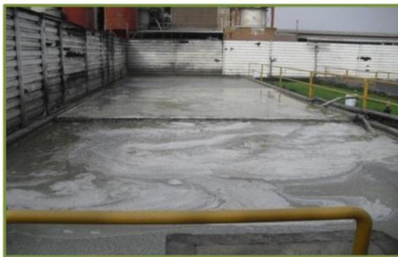
**Figura N°5: Poza de sedimentación primaria de 3 cámaras.**
