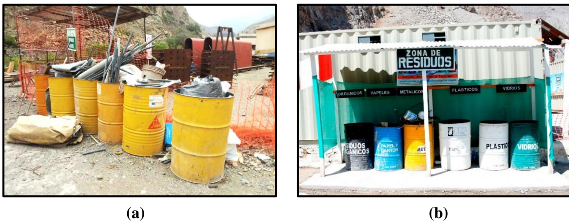
Figura 14: Acondicionamiento de puntos de acopio de residuos no peligrosos: a. antes; b. después
