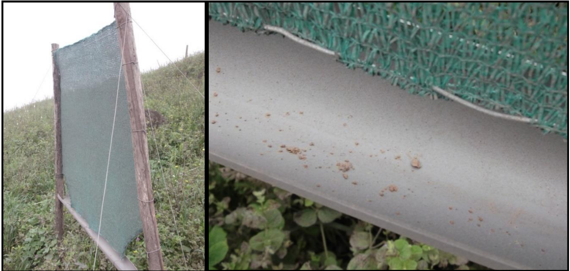
Figura 57: Atrapanieblas instalado en la AA.HH. «12 de junio», al mes de octubre, con rastro de deposición de cemento en la malla, y con rastro de tierra y deposición de cemento sobre la canaleta
