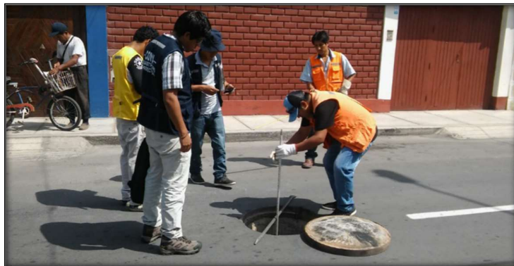
Figura N°12: Verificación de estado de buzones
