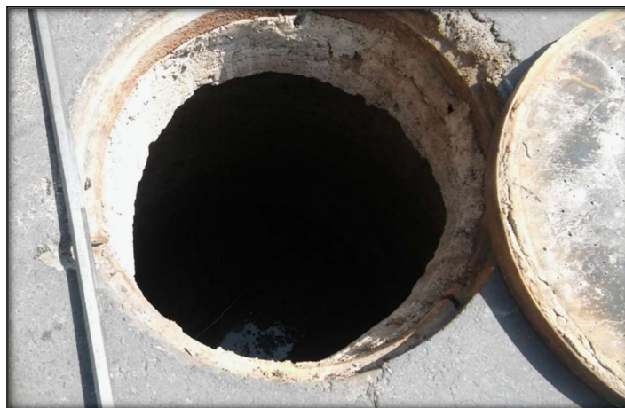
Figura N°13: Estado de Buzón
