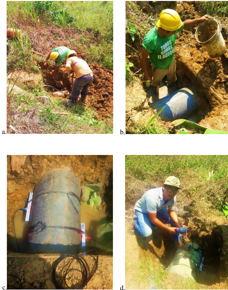
Figura 21: Preparación del punto de control en el Subtronal 3 (km: 1+790.0): excavación (a), limpieza (b), instalación de caudalímetro de tipo flujo ultrasónico (c) y monitoreo de caudal de flujo ultrasónico (d)
