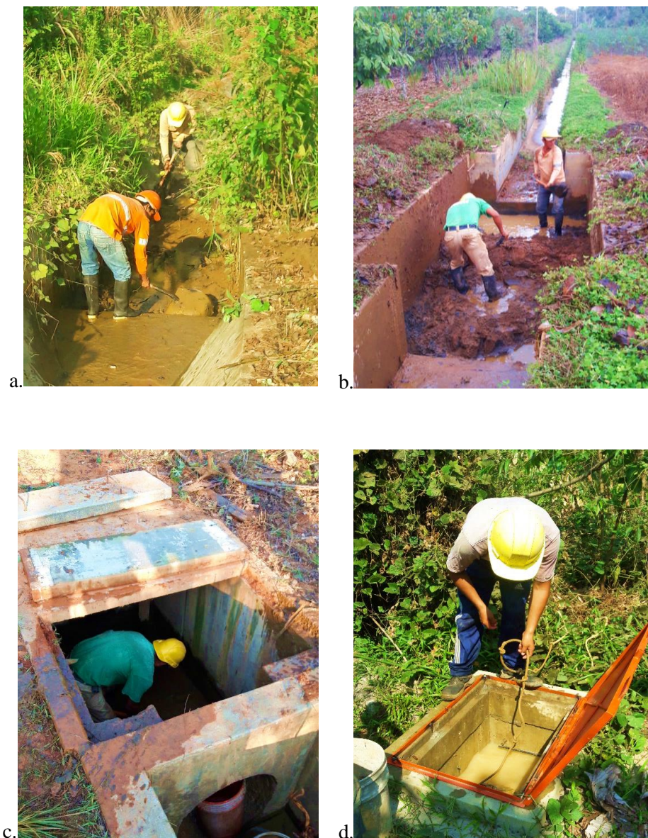
Figura 20: Limpieza en el canal San Ramón de pozas de sedimentación en las progresivas 1+700 (a) y 1+400 (b), toma lateral del Subtronal 3 en la progresiva 1+730.4 (c); limpieza de cámara de purga inundada por lluvias en la progresiva 1+804 del Subtronal 3 (d)
