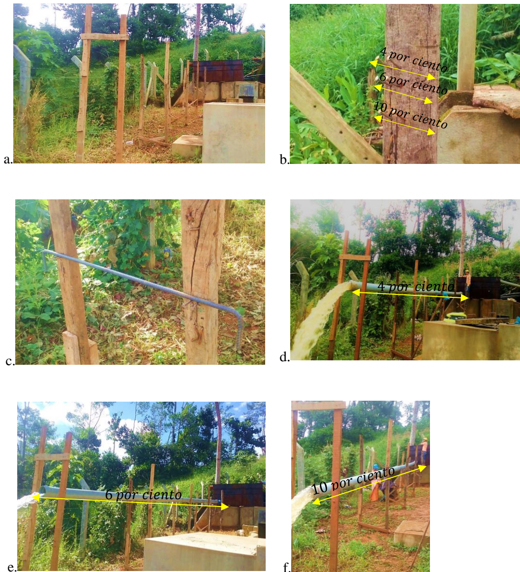
Figura 12: Trabajos preliminares de implementación de parantes (a), colocación de clavos para el soporte de las varillas de acero (b), colocación de varillas de acero (c), prueba de caudal con tuberías de PVC-U 160 mm a pendiente de 4% (d), 6% (e) y 10% (f)
