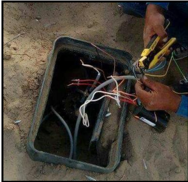
FOTOGRAFÍA N°11: INSTALACIÓN DE UN DECODIFICADOR FD-202
