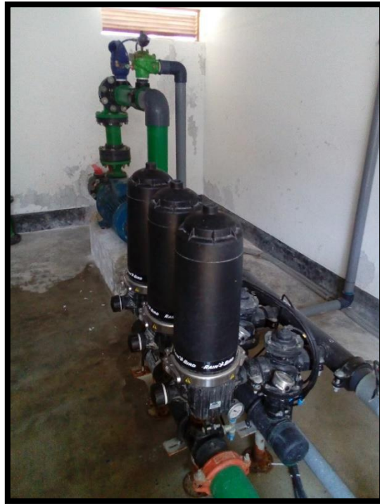
FOTOGRAFÍA N°5: EQUIPO DE BOMBEO - 20 HP – 3 FILTROS ANILLAS
