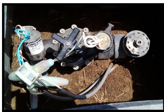
Figura N°20. Válvula MOD PGA y decodificador
