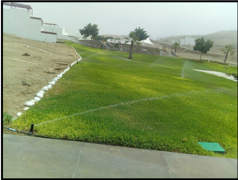
FOTOGRAFÍA N°10: VÁLVULA N°11 – RIEGO CON ROTORES 3500 3.0 BAR
