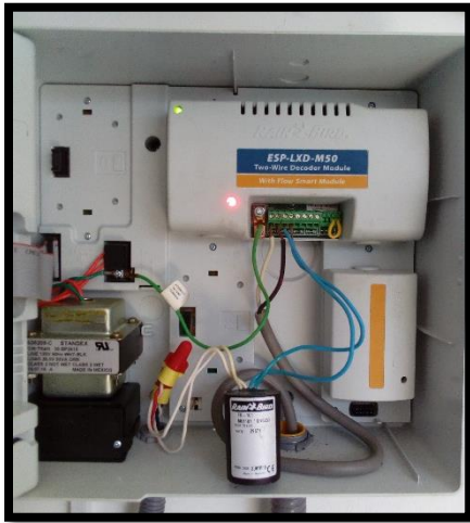
Figura N° 21. Conexión al relé de arranque de bomba 24 VAC – CODIGO 29871
