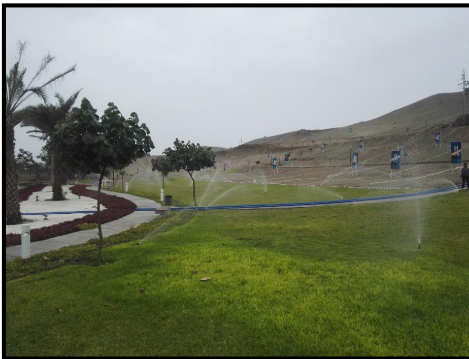
FOTOGRAFÍA N°2: ASPERSORES NUCLEO 2 – RIEGO CON ROTORES 3 BARES
