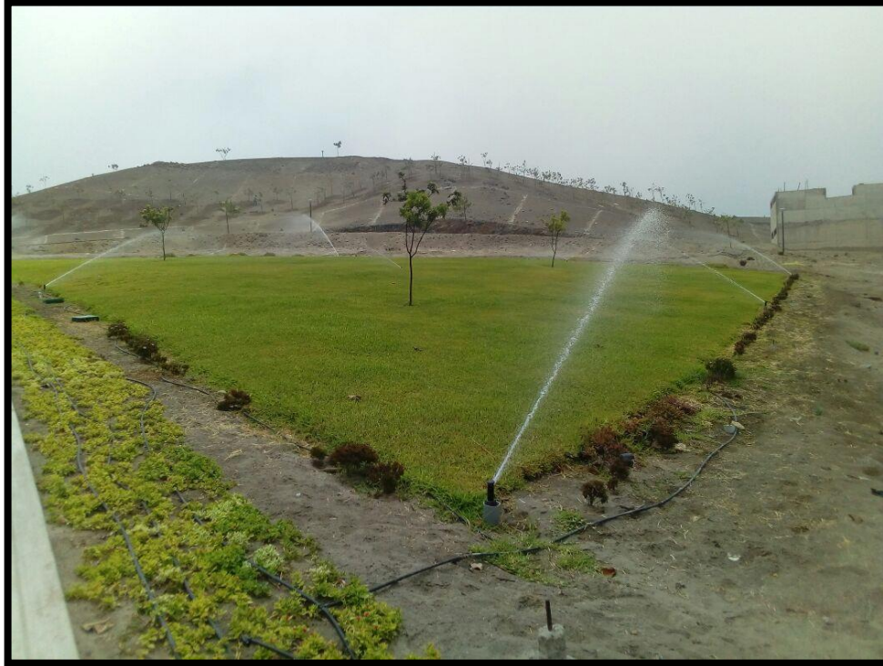
FOTOGRAFÍA N°9: VÁLVULA N°29 – RIEGO CON ROTORES FALCON 4.5 BAR
