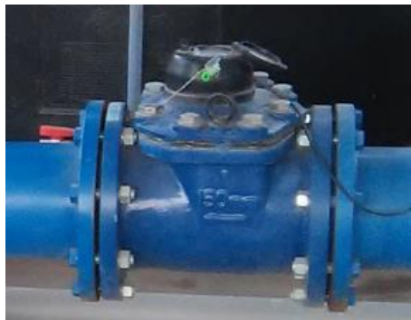
Figura 25: Medidor tipo Woltman de 6"
