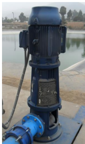
Figura 22: Equipo de bombeo Hidrostral, modelo B08M-H-8
