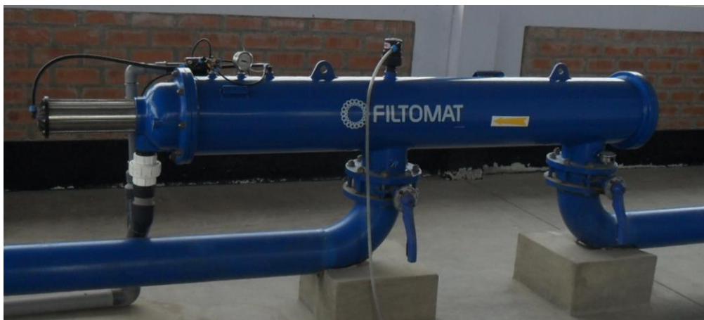
Figura 23: Filtro de mallas FILTOMAT M100 6800 a
