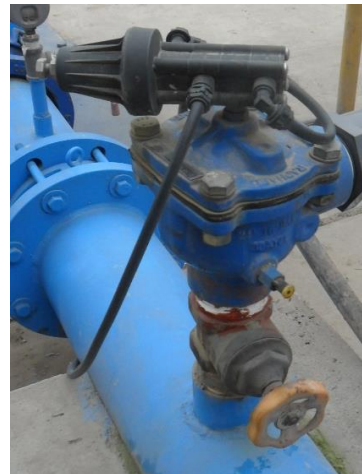
Figura 24: Válvula sostenedora y válvula de alivio
