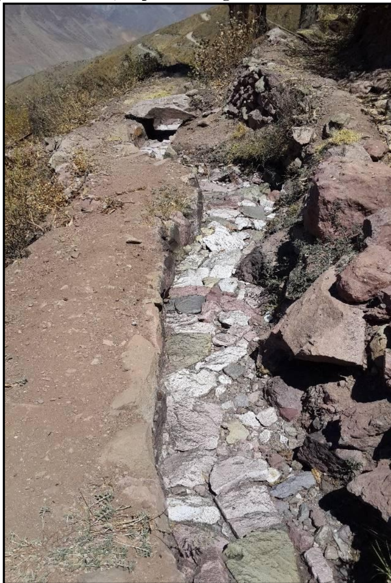
Figura 16. Canal que transporte agua directamente de la represa de Ururi hacia zonas bajas de Tupicocha. Lanzasa, Tupicocha – Agosto 2015
