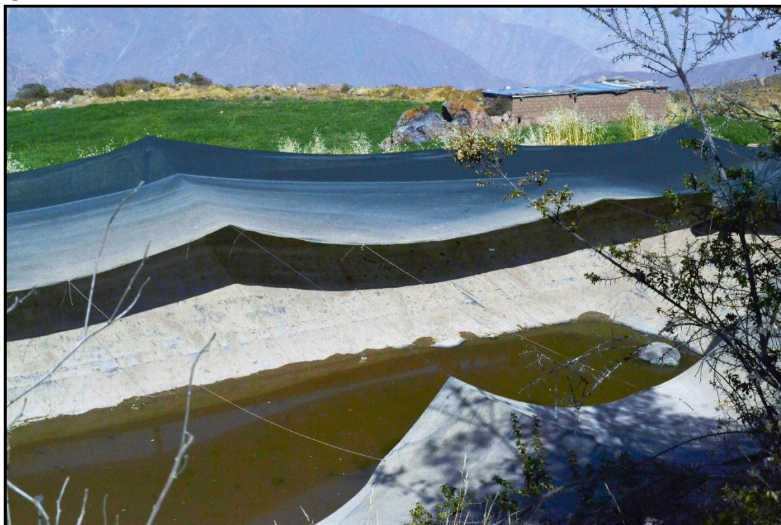
Figura 15. Geomembrana recubriendo un manantial familiar. Cancasica, Tupicocha - Agosto 2015
