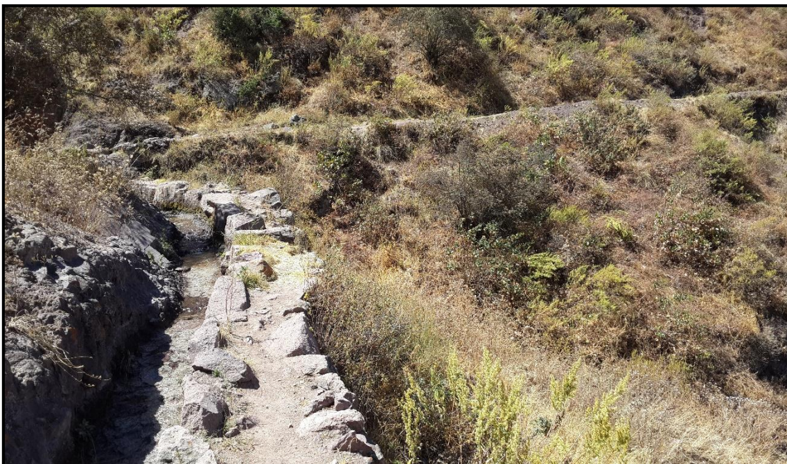
Figura 18. Camino de vigilancia al costado del canal. Tupicocha – Agosto 2015
