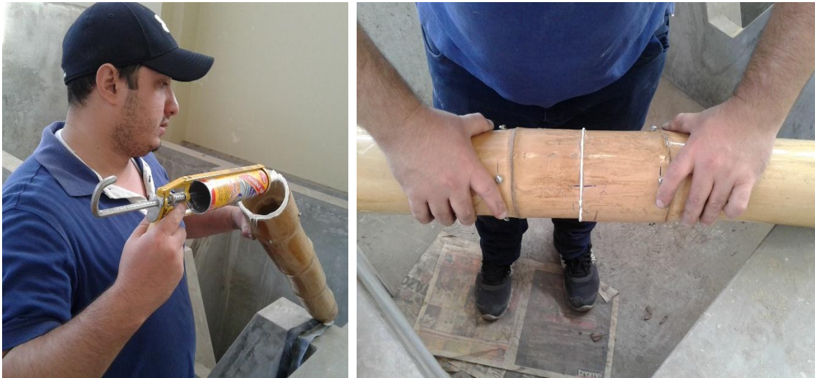
Figura 3.13: Pegado de los tramos de bambú.
