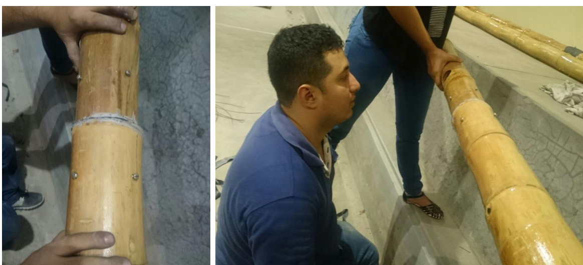
Figura 3.12: Unión de los tramos de bambú.
