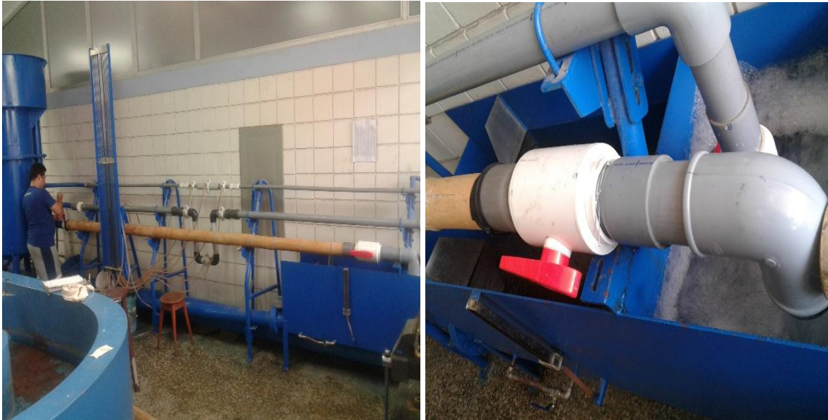
Figura 3.3: Montaje de las tuberías de bambú
