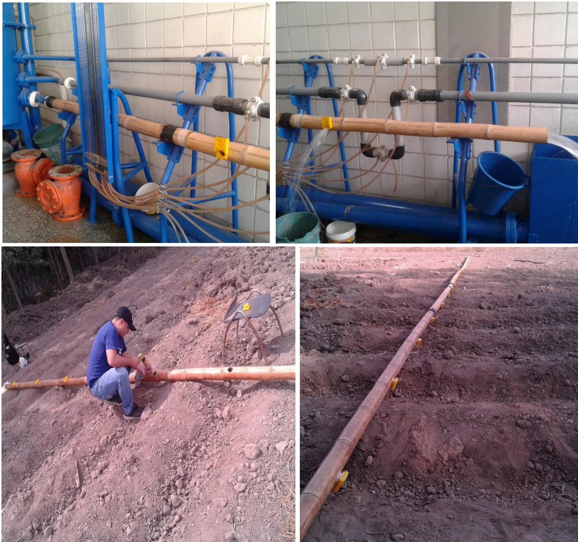
Figura 3.16: Instalación de las multicompuertas.
