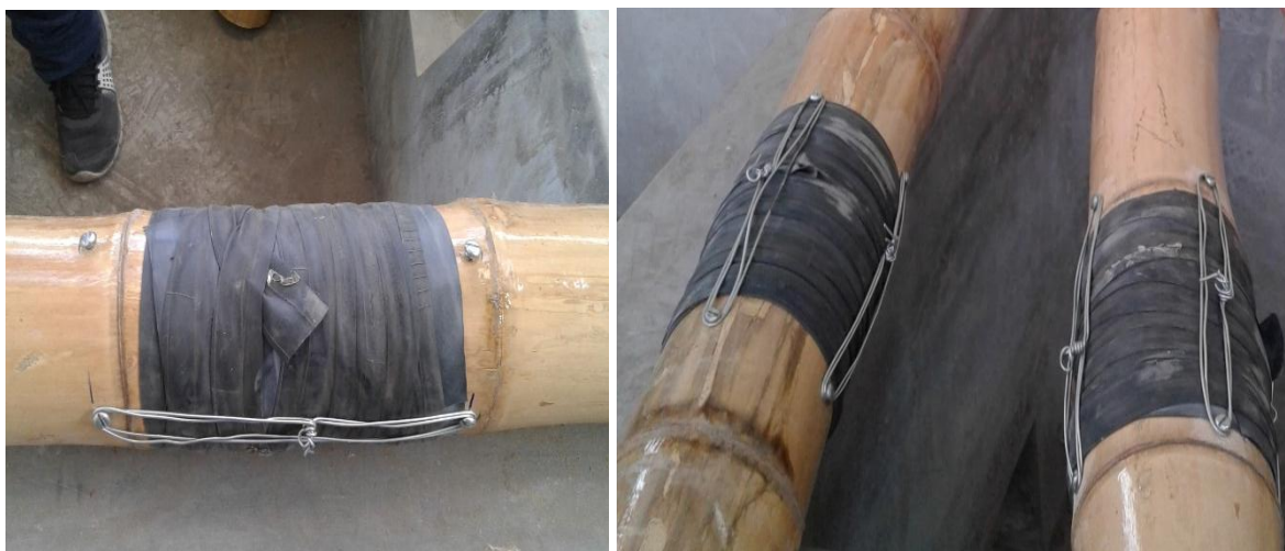
Figura 3.15: Tensado de los tramos bambú.
