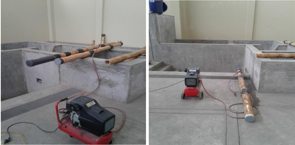
Figura 3.7: Prueba de resistencia a la presión.
