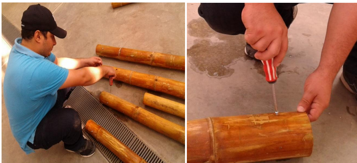
Figura 3.11: Taladrado y atornillado de los tramos de bambú.
