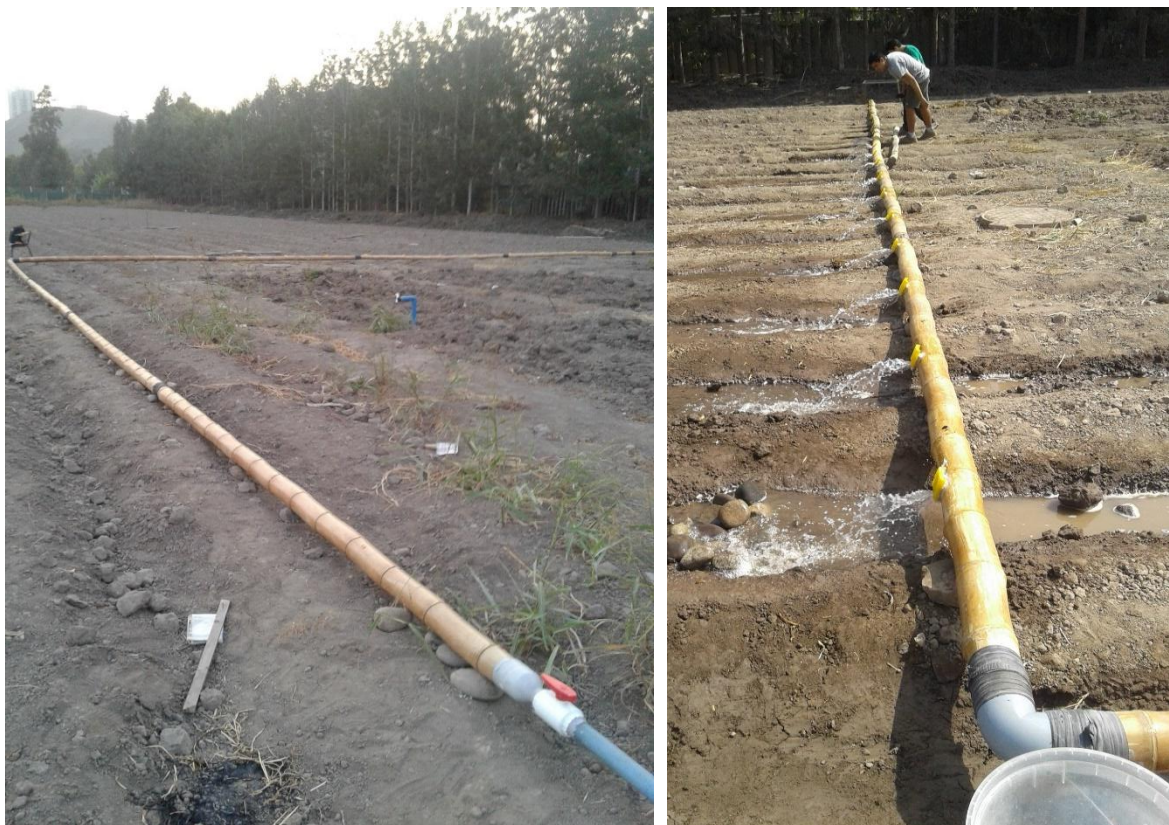
Figura 3.17: Instalación del sistema de riego de bambú al campo experimental.
