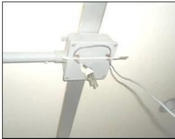
Figura 3: Sensores de temperatura – etapa múltiple
