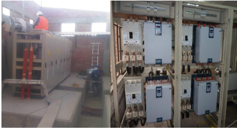
Figura 18. Montaje de los tableros eléctricos del equipo de bombeo
