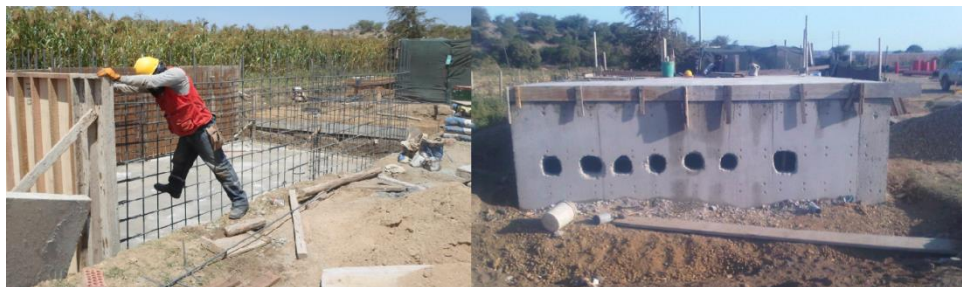
Figura 16. Construcción de la poza de almacenamiento y desarenadores
