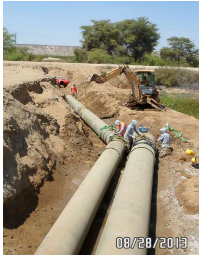
Figura 8. Instalación de codos de las aducciones
