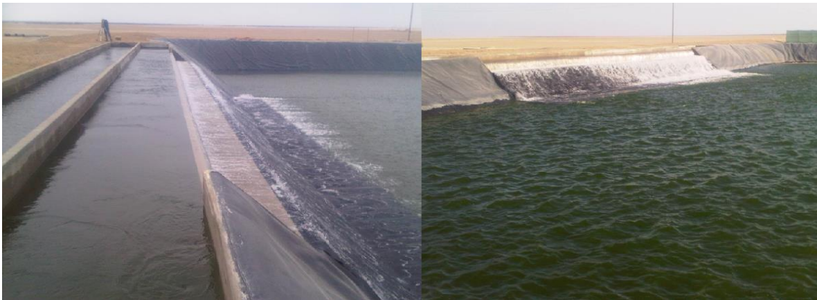
Figura 23. Entrada de agua a los reservorios 02 y 03
