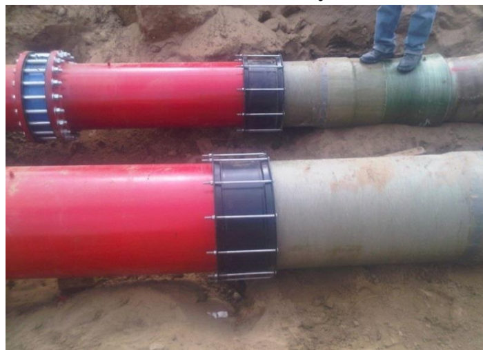
Figura 20. Conexión entre las caldererías de acero y las aducciones de PRFV
