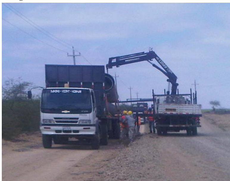
Figura 6. Descarga de las tuberías de los camiones
