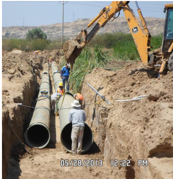
Figura 7. Instalación de tuberías de PRFV
