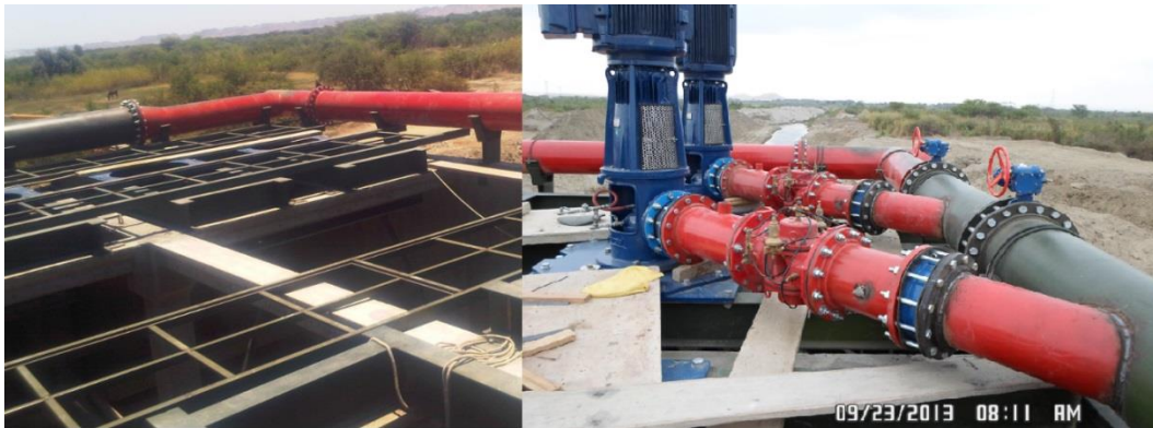
Figura 19. Montaje de las caldererías sobre la toma del río
