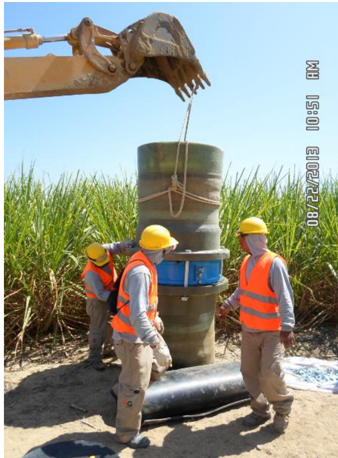
Figura 10. Montaje de las válvulas check de las aducciones
