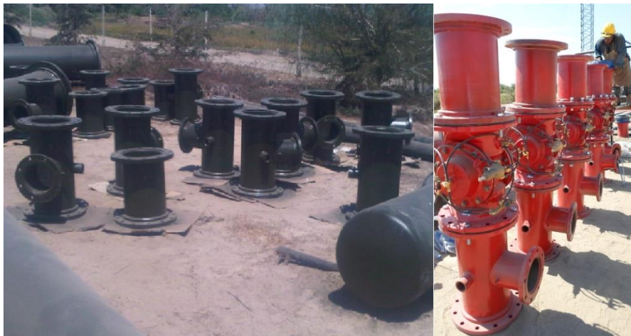
Figura 12. Pintado de las caldererías de acero
