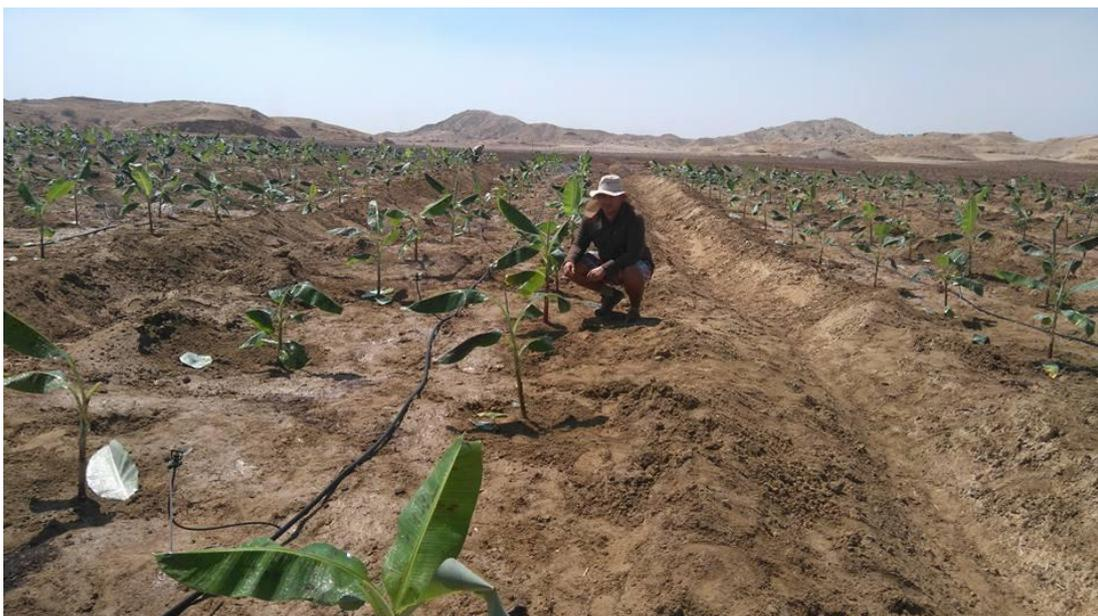
**Figura 12: Instalación de manguera ciega 20mm – Laterales de riego**
