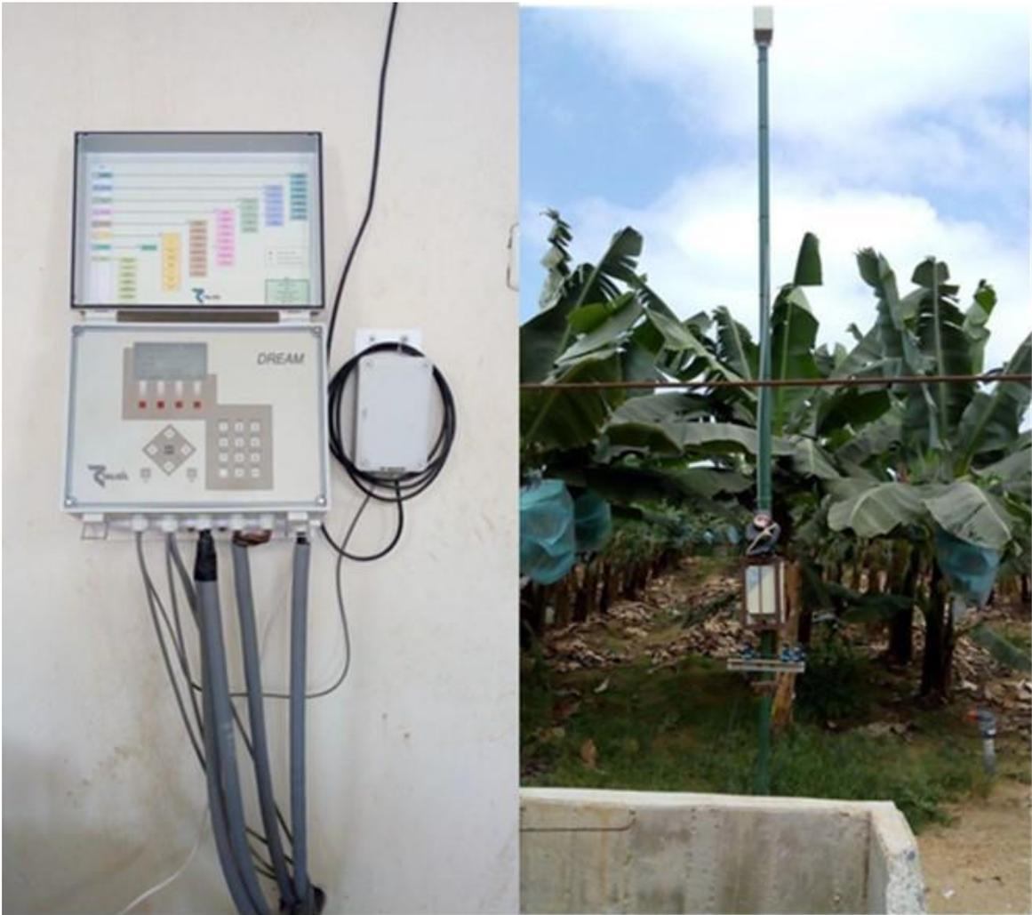
**Figura 14: Programador de riego, RTU (Unidad Remota)**
