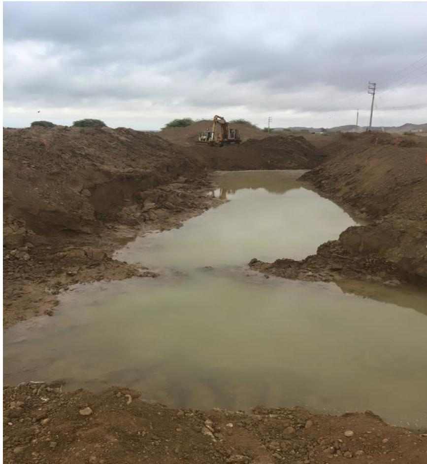
**Figura 9: Movimiento de tierras y construcción reservorio**
