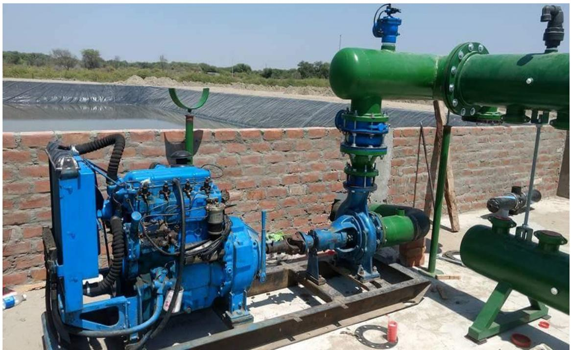
**Figura 6: Lado descarga de agua**
