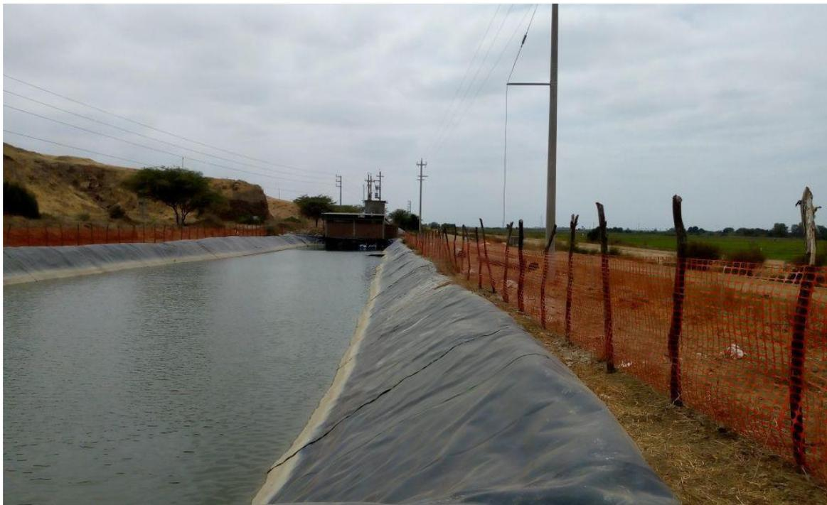
**Figura 3: Reservorio impermeabilizado con geomembrana HDPE de 1.0mm**
