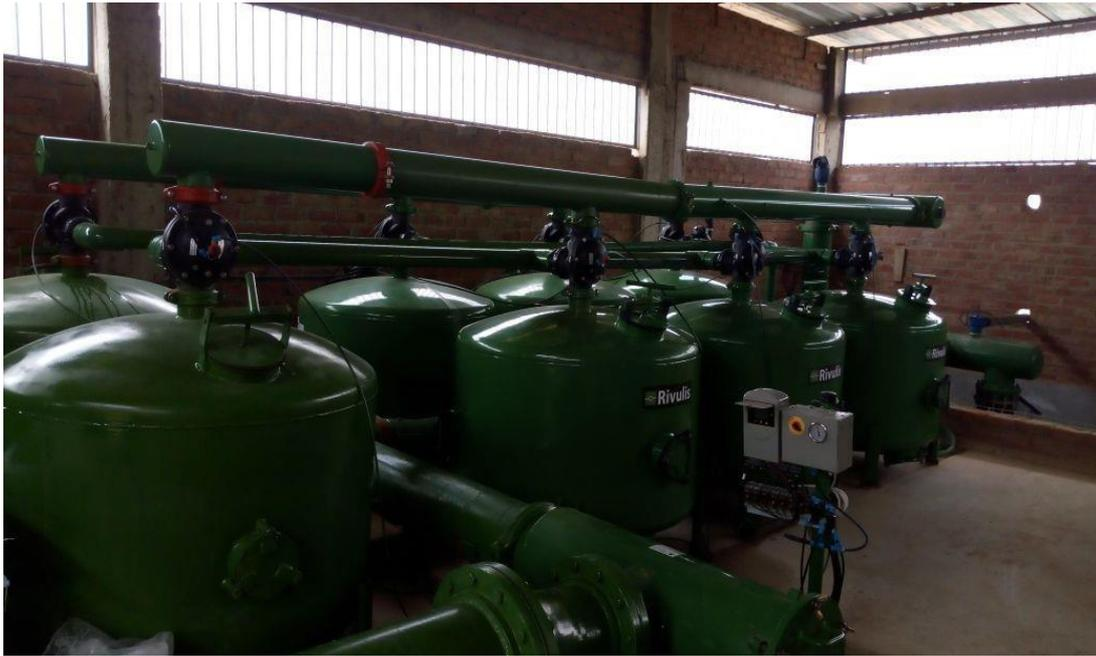
**Figura 7: Sistema de filtrado de agua**
