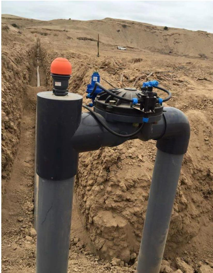
**Figura 11: Válvula hidráulica de control**
