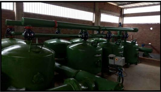
IMG 2. SISTEMA DE FILTRADO (TANQUES DE GRAVA)
