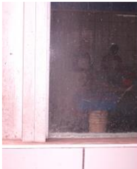
Figura 14: Falta de limpieza en ventanas
