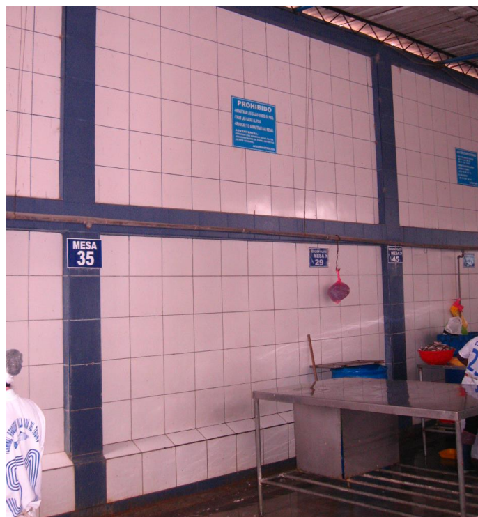
Figura 10: Superficie de las paredes recubiertas de mayólicas
