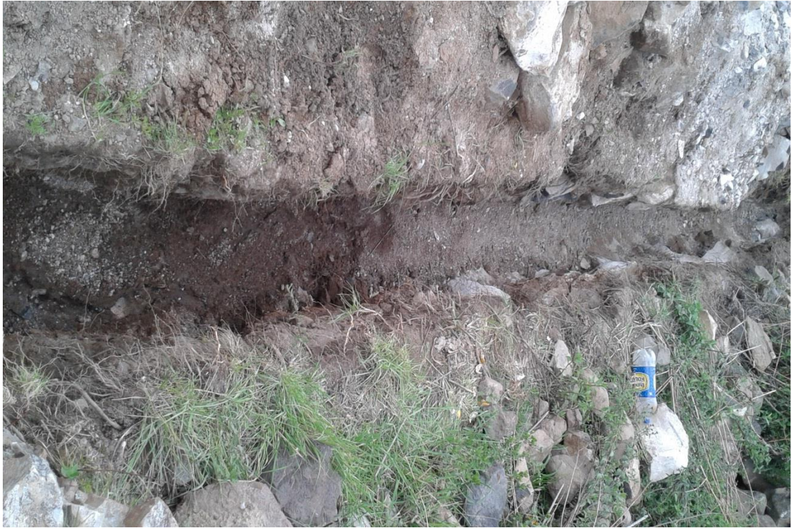
Figura 20: Zanja excavada para tendido de tubería principal (SISRIEGO S.R.L, 2015)
