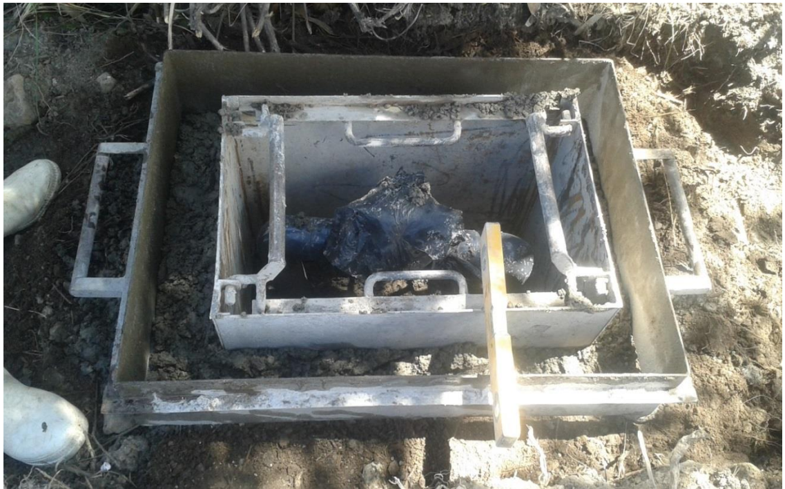
Figura 25: Construcción de caja de concreto para protección de arco de riego (SISRIEGO S.R.L, 2015)
