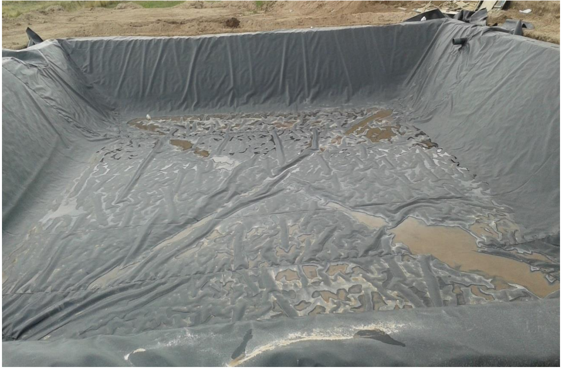
Figura 22: Reservorio revestido de geomenbrana de HDPE 0.75 mm (SISRIEGO S.R.L, 2015)
