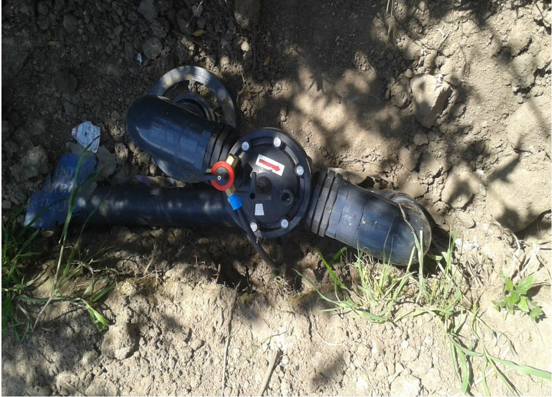
Figura 24: Arco de riego instalado (SISRIEGO S.R.L, 2015)
