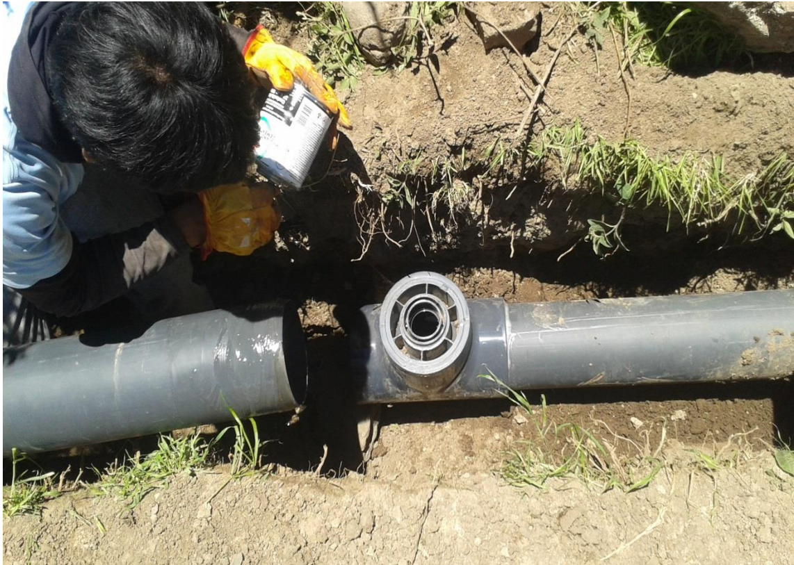
Figura 23: Salida de arco de riego (SISRIEGO S.R.L, 2015)
