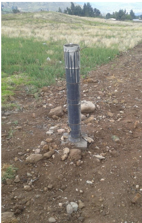
Figura 26: Construcción de pedestales de concreto para soporte de aspersores (SISRIEGO S.R.L, 2015)
