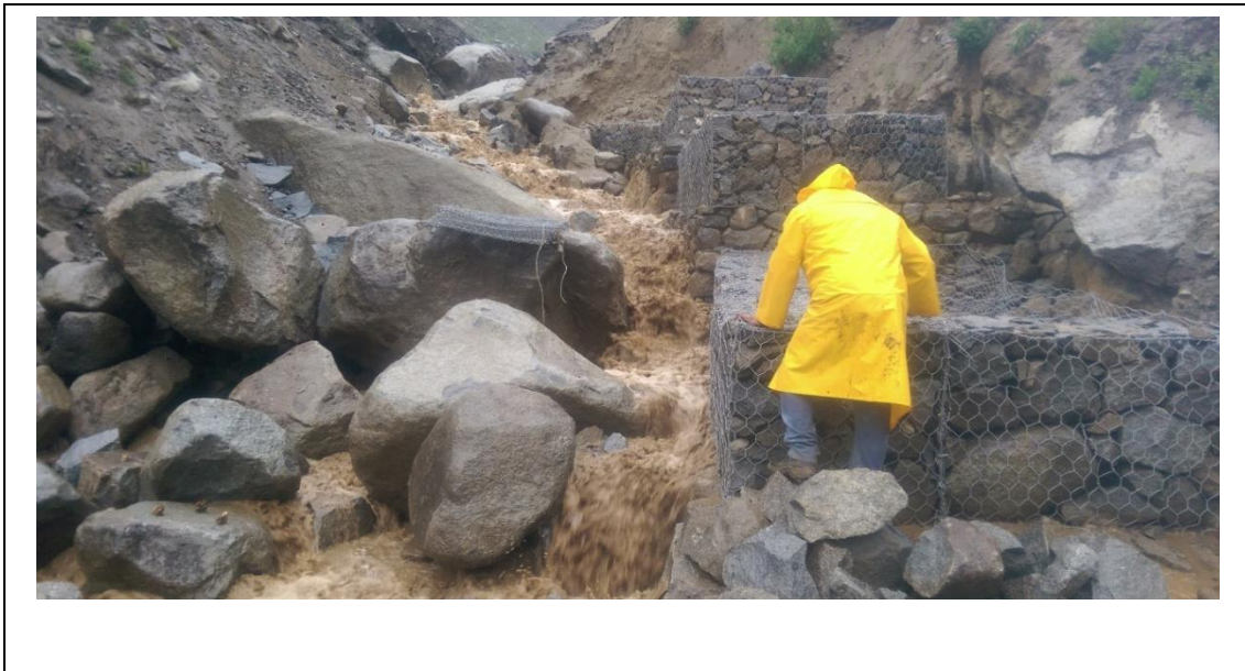
Foto Nro. 9 Gaviones instalados.
