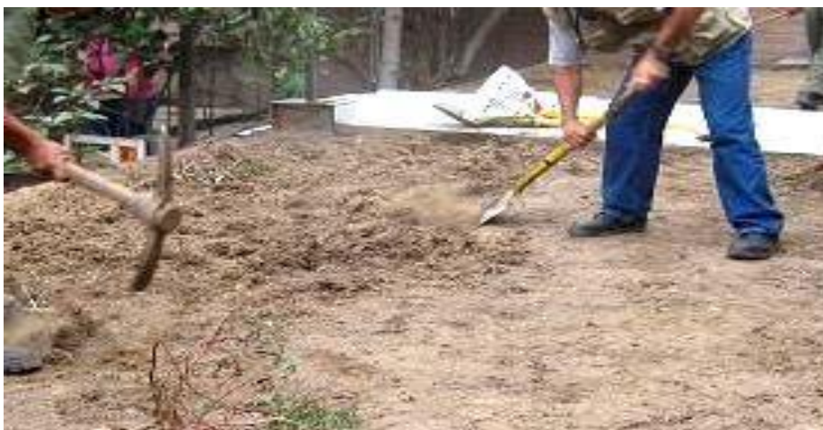
Figura 19. Preparación del terreno
