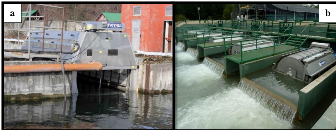
Figura 28: Filtro tipo bastidor de la serie 200. Detalle de la entrada (a) y salida de agua (b). (Fuente: Ficha técnica de filtro de tambor de la serie 200. Disponible en: www.faivre.fr/index.php/en/ ).
