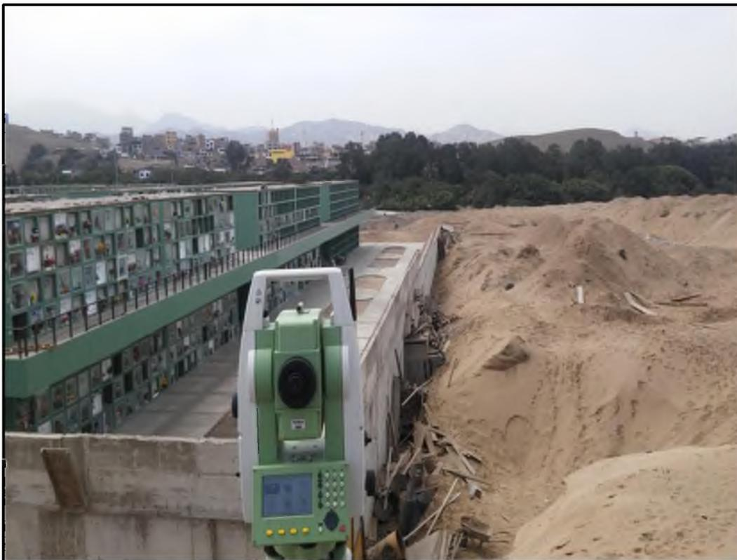
**Foto N°05:** En la imagen se muestra el registro de datos con Estación Total.
