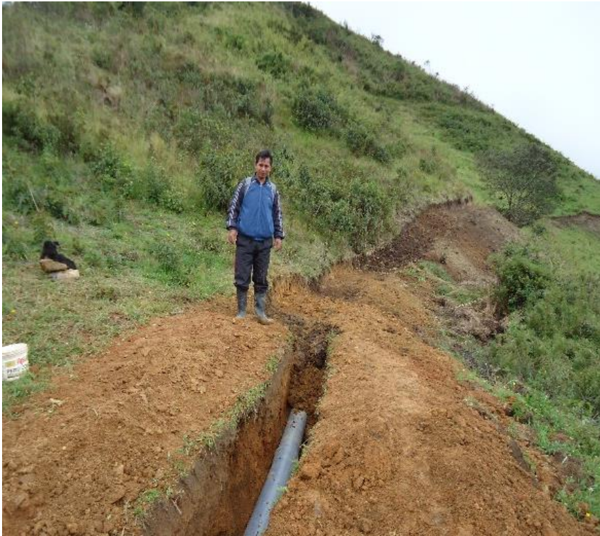
Imagen 05: Instalación de tuberías.
