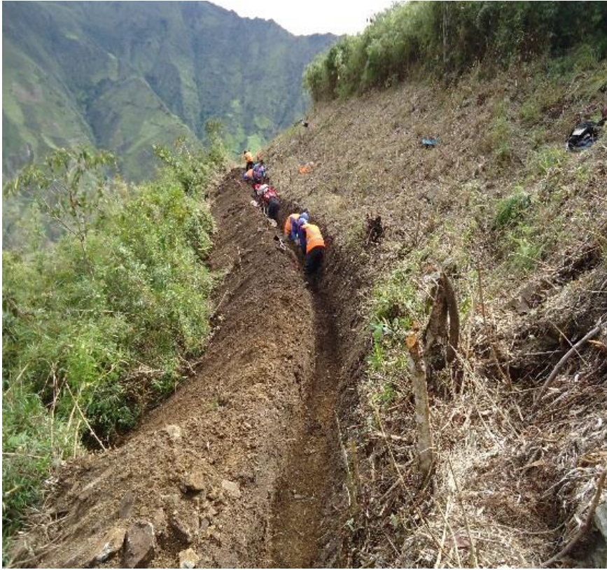
Imagen 03: Trabajos de excavación.
