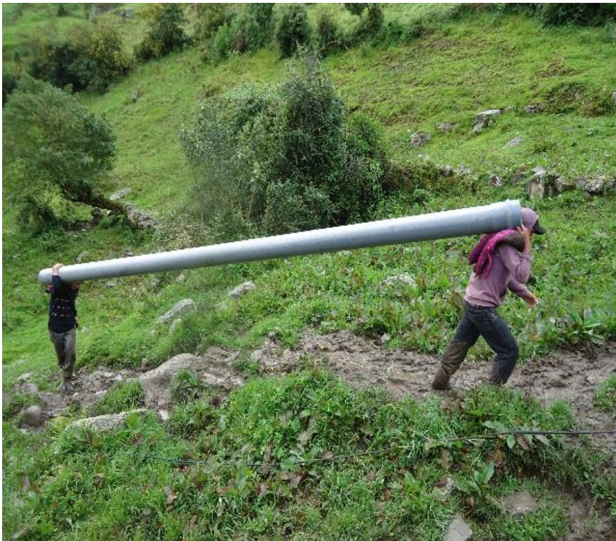
Imagen 04: Acarreo de tuberías.
