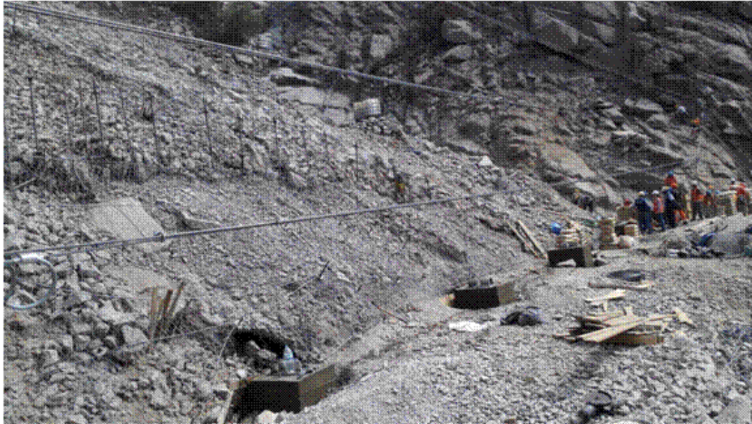
Figura 30: Instalación de cables horizontales y perimetrales.
