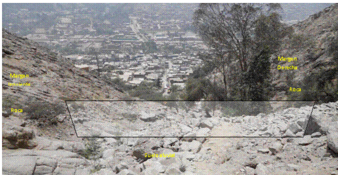
Figura 20: Foto de la ubicación de la Barrera N°11. - Quebrada Carosio
