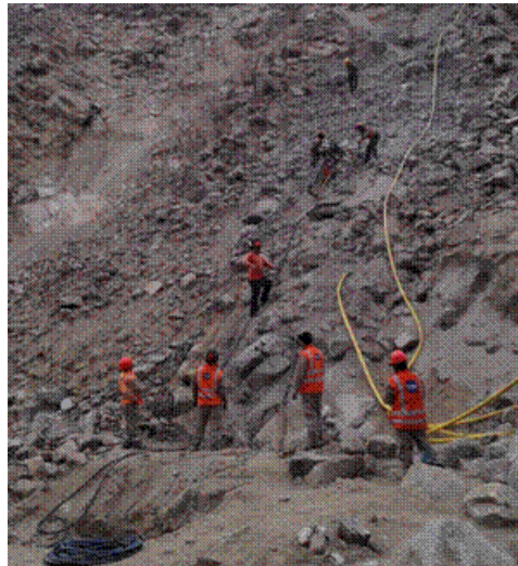
Figura 25: Marcado de puntos para perforación.
