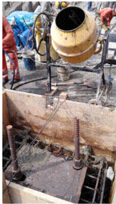
B) Construcción de cimentación
