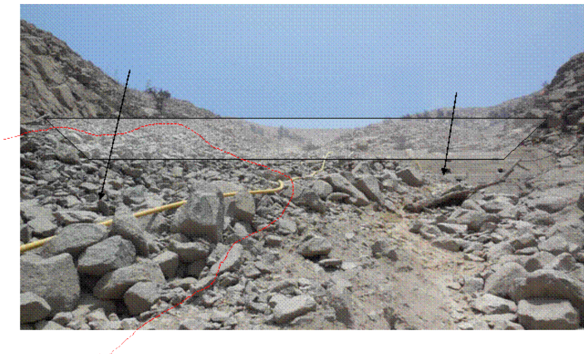
Figura 19: Foto de la ubicación de la Barrera N°10- Quebrada Carosio
