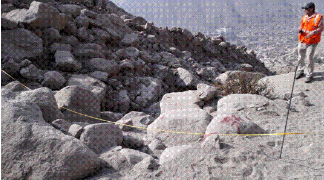
Figura 23: Inicio de replanteo de ubicación de la barreras dinámicas con wincha y estacas.
