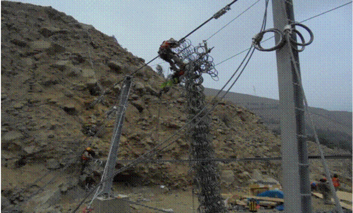
Figura 32: Colocación de malla de protección.
