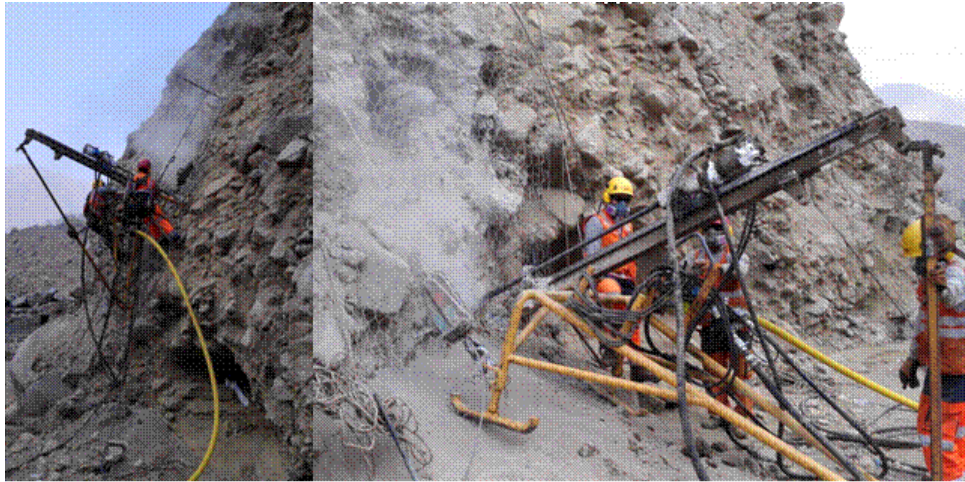
A) Perforación en taludes, altura de 2 metros B) Perforación en taludes, cota 0.
