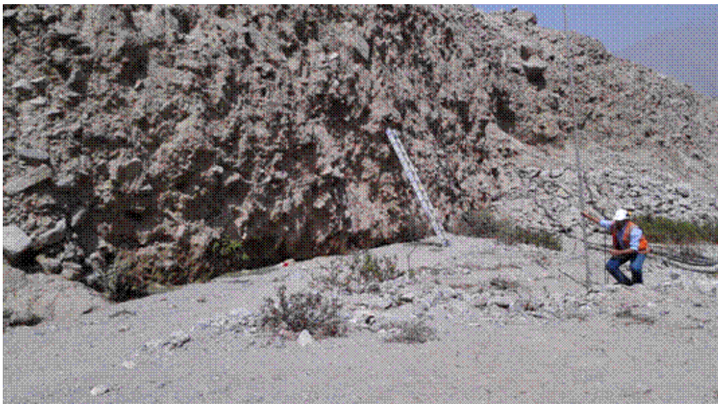
Figura 24: Marcación de puntos de los postes con wincha y pintura
