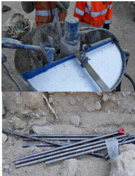
A) Preparacion de la mezcla; suelo /cemento y B) Pernos
