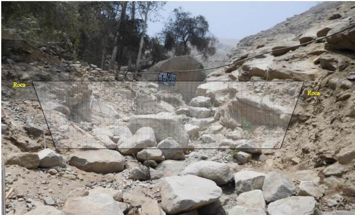
Figura 21: Foto de la ubicación de la Barrera N°12. - Quebrada Carosio
