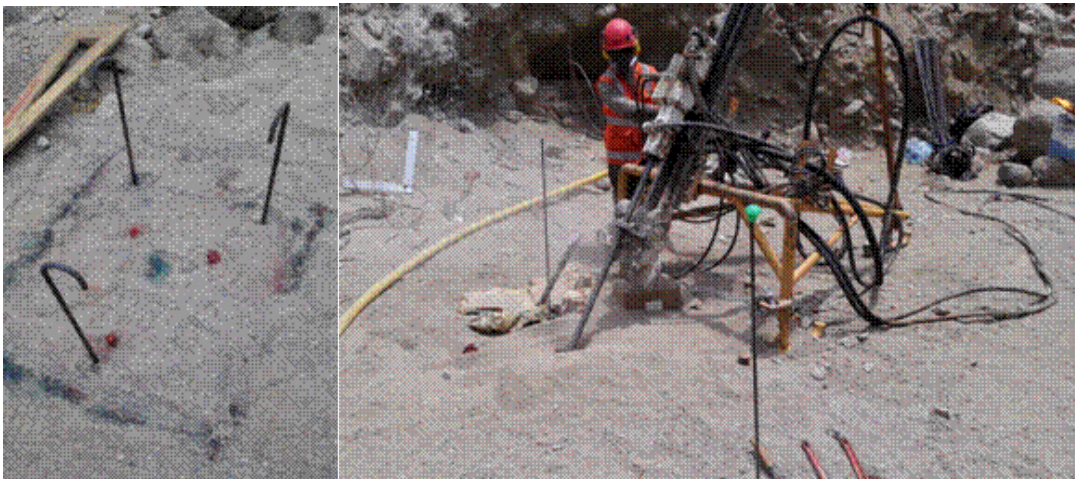
A) Marcado de anclajes para los postes, con estacas de acero 3/4" y B) Perforación de puntos de anclaje
