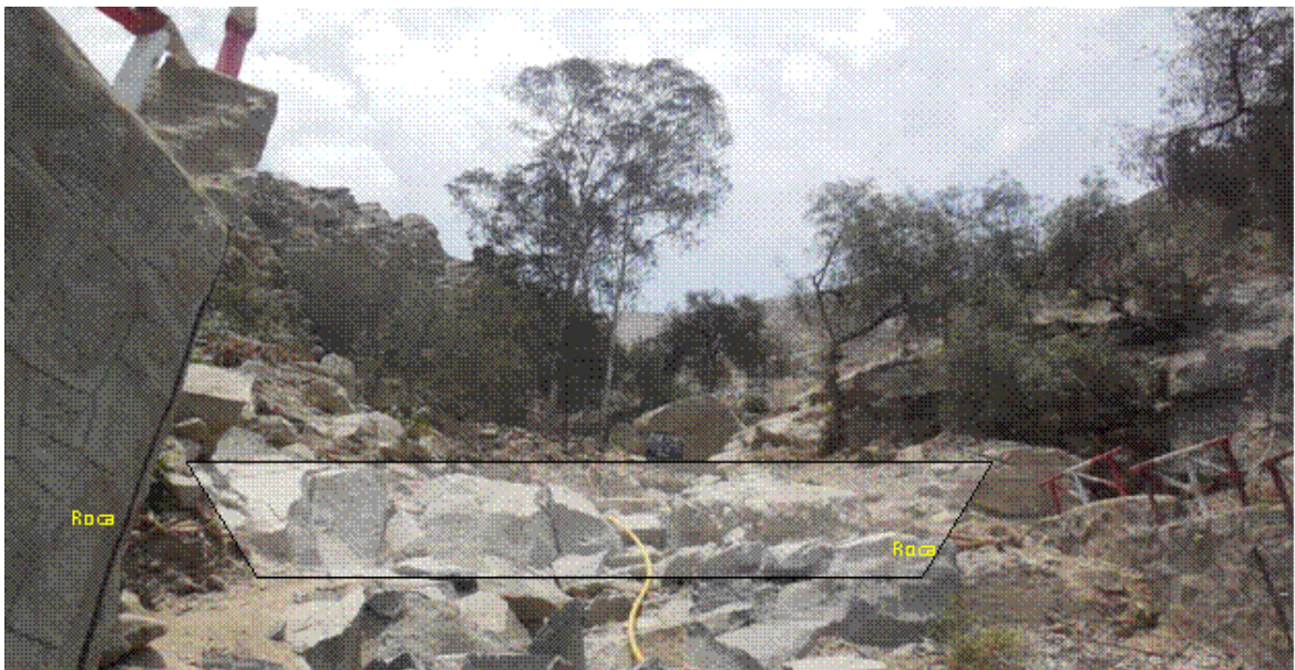
Figura 22: Foto de la ubicación de la Barrera N°22- Quebrada Carosio
