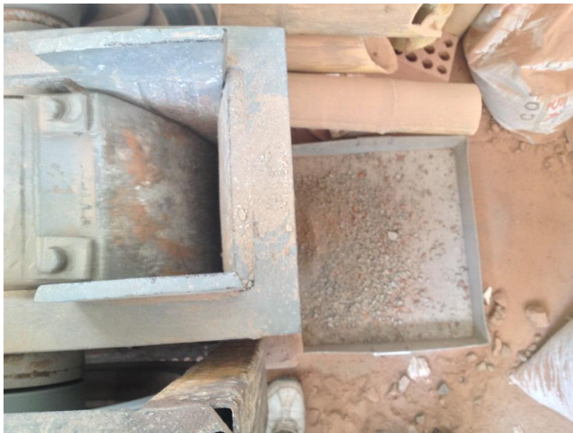
Trituración de los escombros
