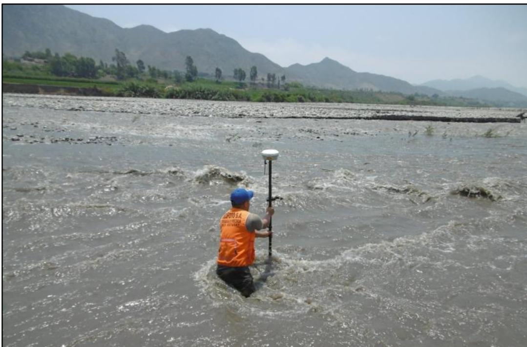
**Figura 21. Operador realizando levantamiento topográfico.**
