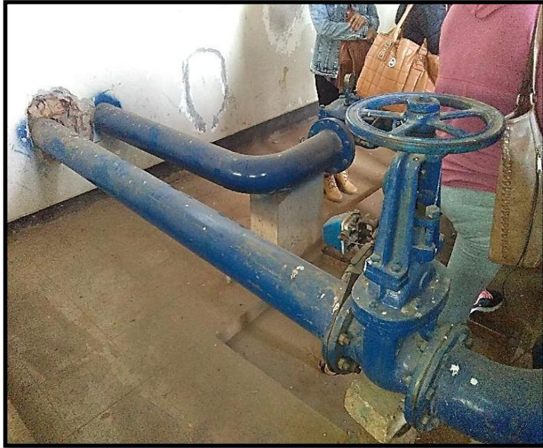
**Figura 36: Llave y tuberías del pozo Chino 2 que llevan el agua al canal exterior**
