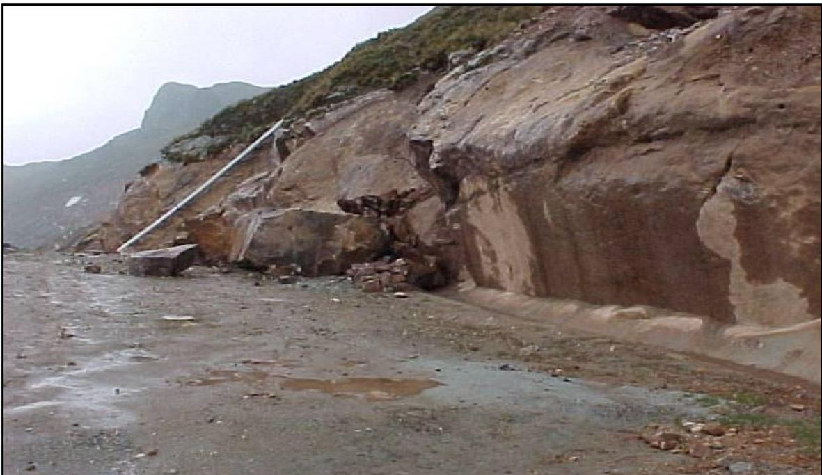
**Figura 6 : Deslizamiento de rocas sobre canal Canrash (talud de corte)**
