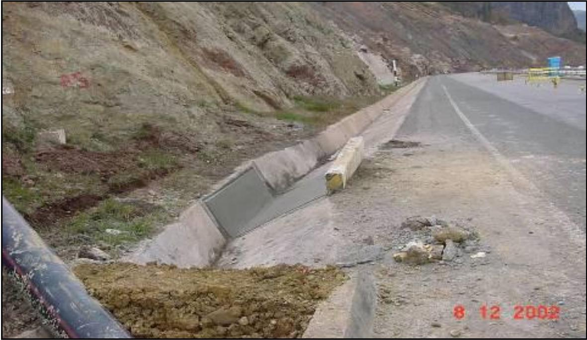
**Figura 7 : Reparación de cuneta en el km 94 del sector Canrash (año 2002)**
