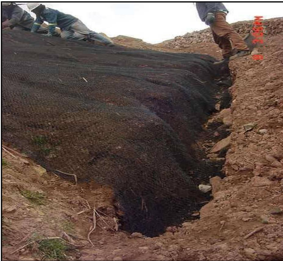
**Figura 18 : Anclaje de enkamat al pie de talud de relleno. Sector Canrash km 94**
