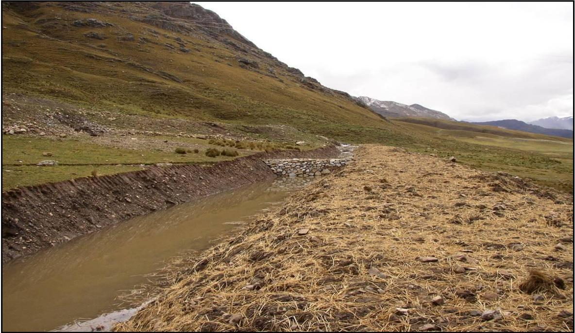
**Figura 17: Zanja de lagrimeo (Weeb berm). Sector Canrash**
