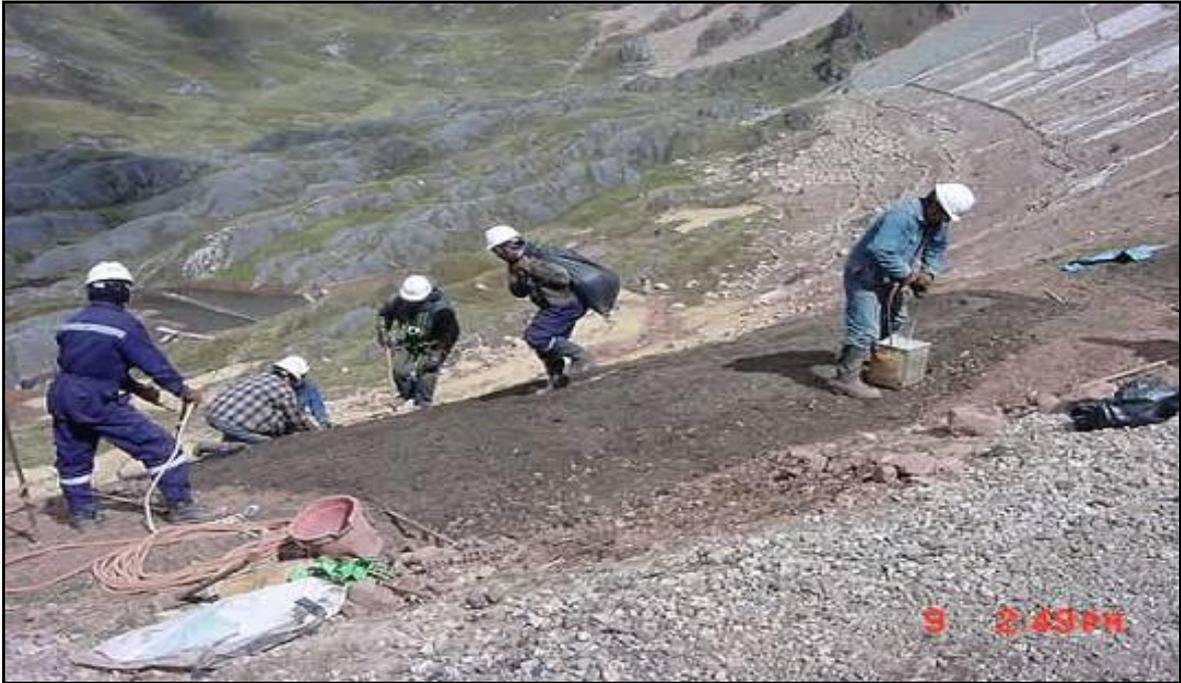
**Figura 21 : Colocación de top soil sobre enkamat. Sector Canrash km 94 (año 2001)**
