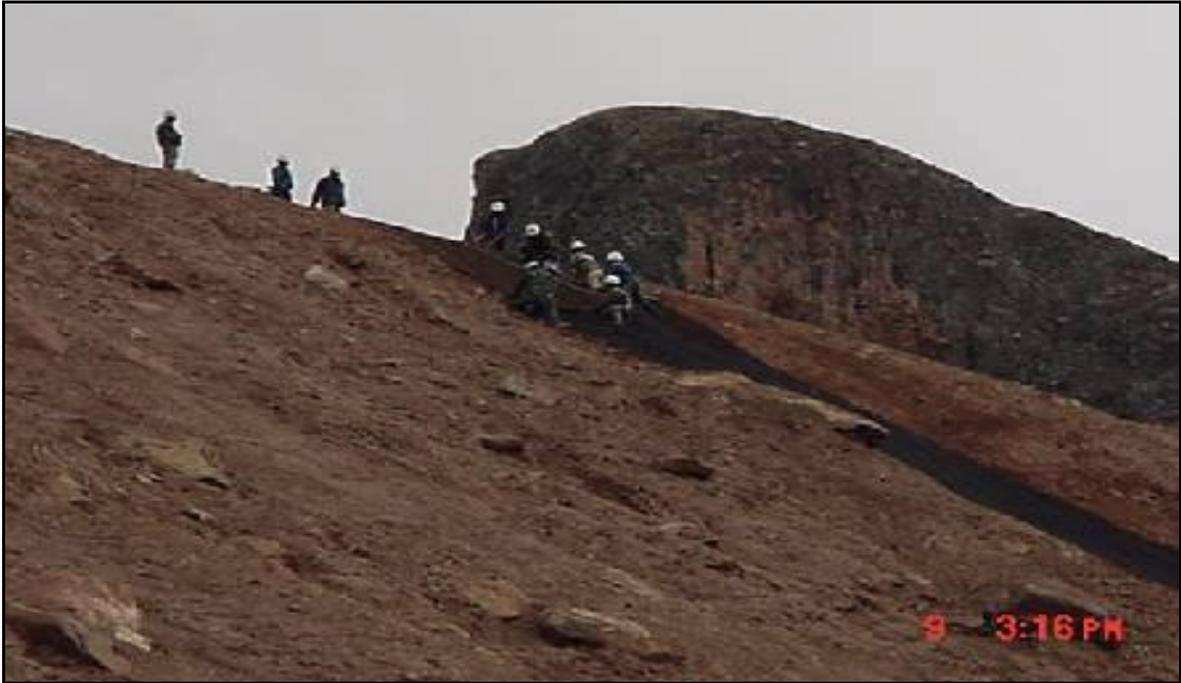
**Figura 19 : Colocación de enkamat en talud de relleno. Sector Canrash km 94**
