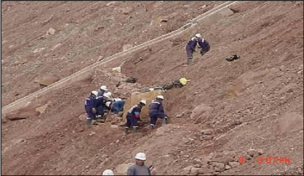
**Figura 11 : Preparación de talud de relleno para colocación de mantas de enkatamat.**
