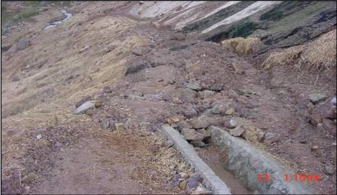
**Figura 5: Deslizamiento sobre canal km 94 Canrash año 2001(talud de relleno)**
