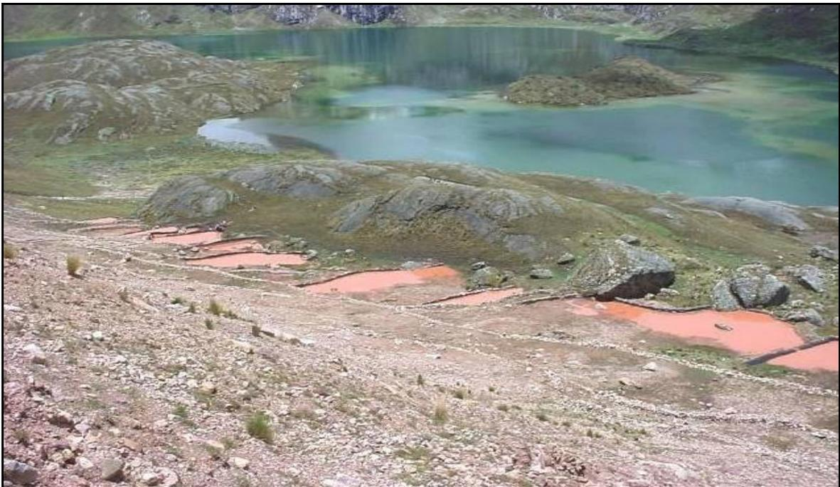
**Figura 14: Sistema de sedimentación en la laguna de Canrash (km 94)**
