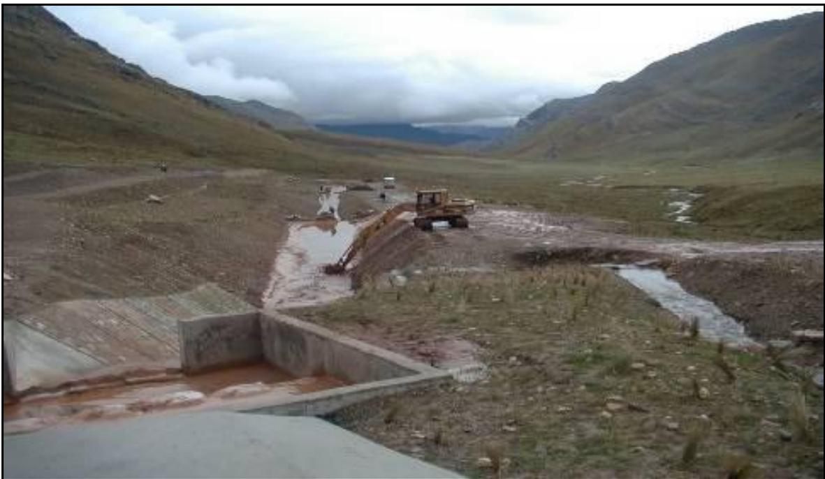
**Figura 16 : Limpieza de pozas de sedimentación km 97 Canrash**
