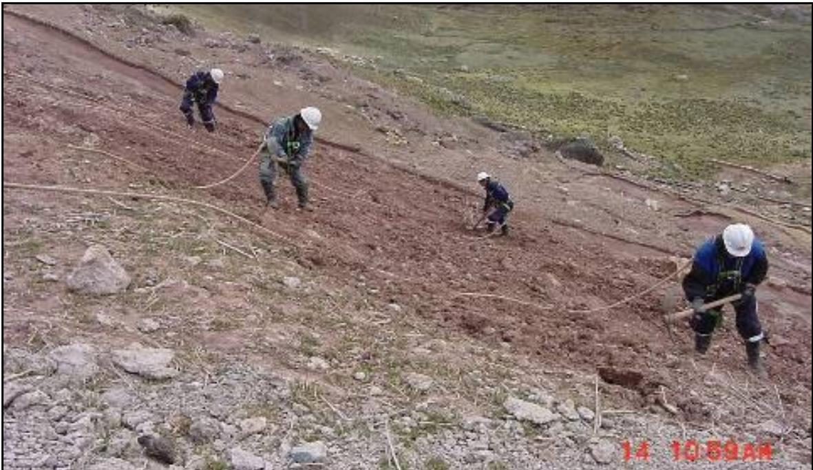
**Figura 10 : Preparación de talud de relleno en Canrash**
