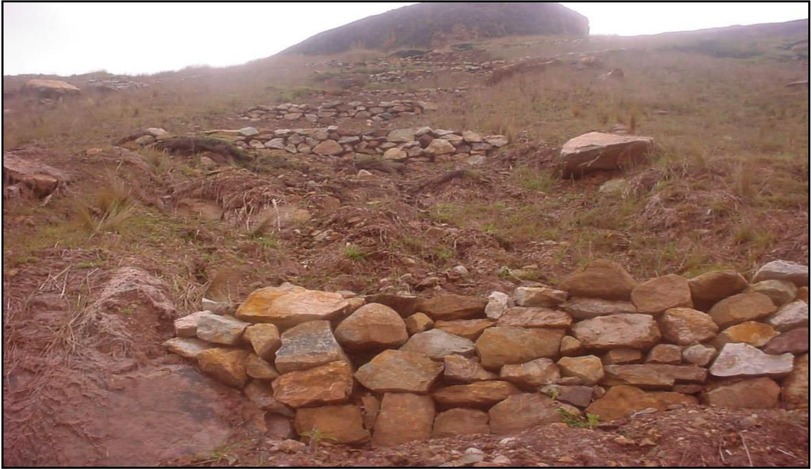
**Figura 23 : Sistema de muros de roca en talud de relleno Canrash para restaurar áreas con cárcavas (año 2003)**
