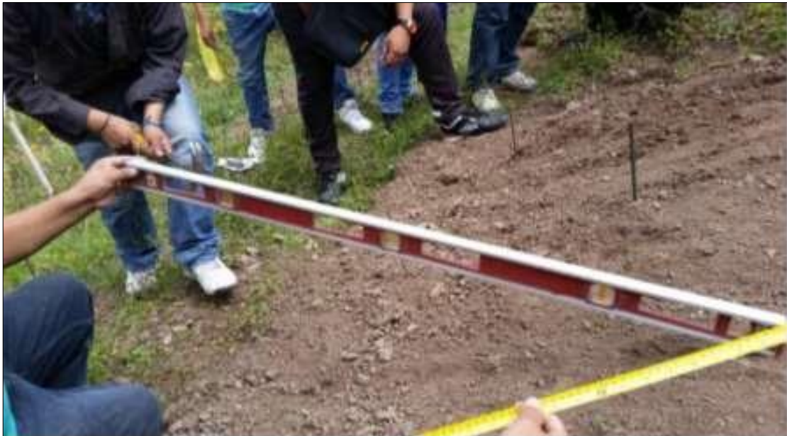
Fotografía 6. Medicion de pendiente
