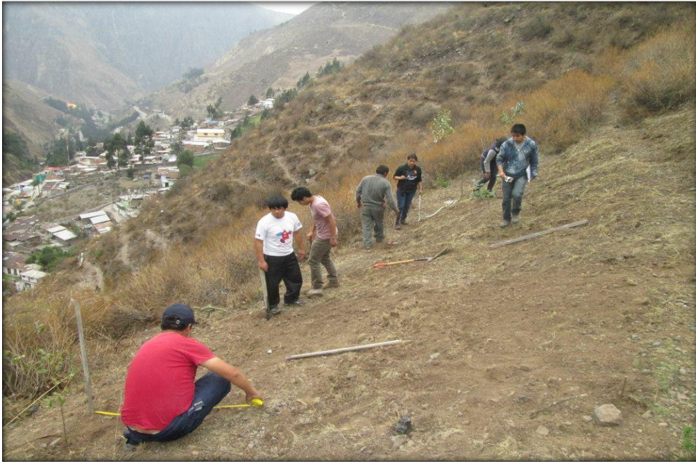
Fotografía 1. Limpieza del área del proyecto
