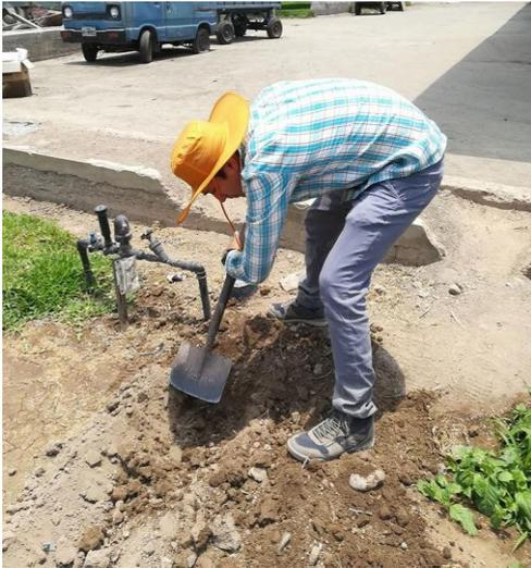
**Figura 64:** Excavación de zanjas para los conductores eléctricos.
