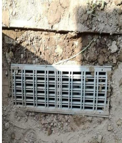
**Figura 79: Rejilla de PVC que protege al sensor de flujo de agua de 1"**
