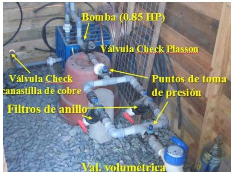
**Figura 21: Cabezal de riego y sus principales componentes.**
