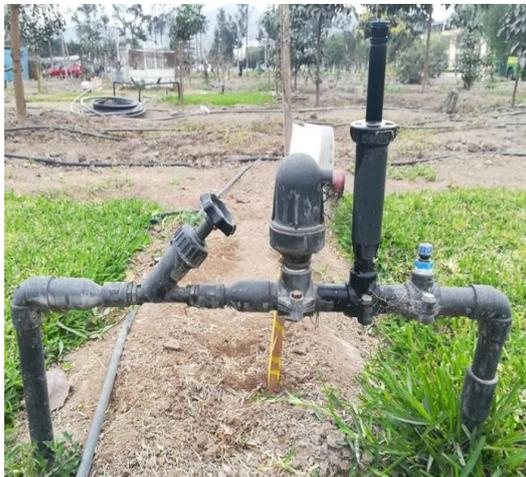
**Figura 76: Arco de riego de la subunidad 2 en funcionamiento.**
