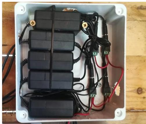
**Figura 68: Instalación del tablero donde se alberga a los transformadores de 12V para las válvulas solenoides.**
