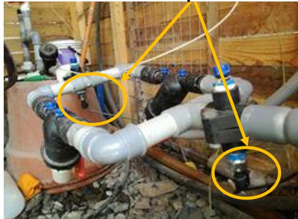
**Figura 33: Sensor de presión antes y después del filtro.**
