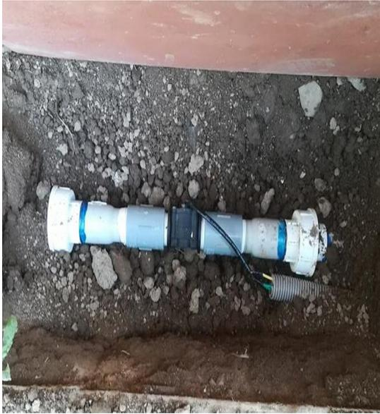
**Figura 78: Sensor de flujo de agua de 1" instalado en la tubería principal**
