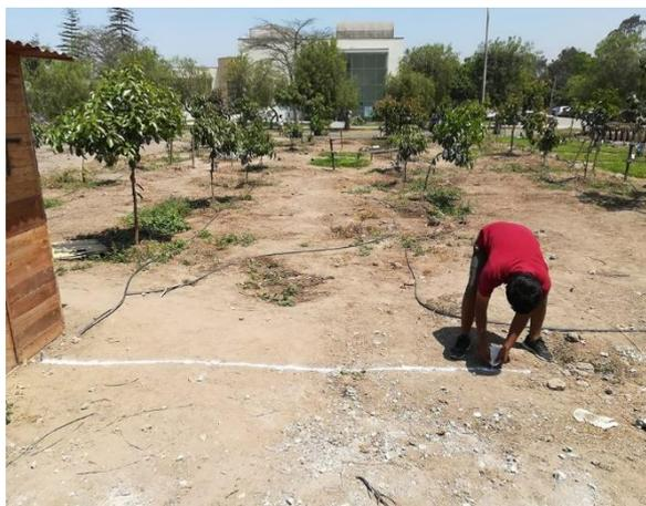
**Figura 63: Delimitación de la zanja para los conductores eléctricos.**
