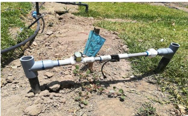
**Figura 70: Instalación del arco de riego automatizado**
