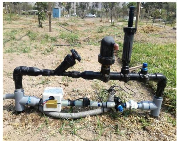
**Figura 77: Arco de riego de la subunidad 2 en funcionamiento.**
