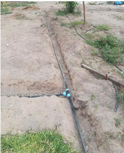
**Figura 66:** Instalación de la manguera de polietileno para conducir los cables eléctricos.
