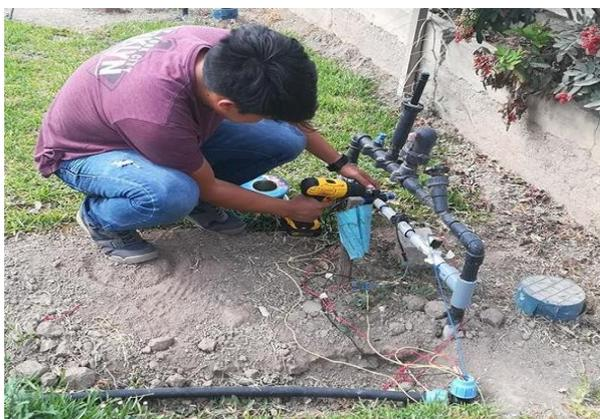
**Figura 72: Instalación de los sensores de presión en las subunidades**
