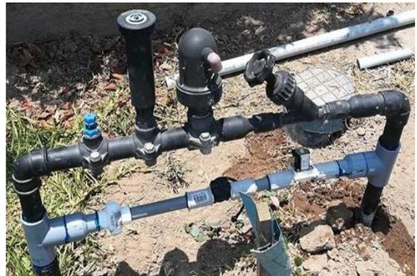
**Figura 71: Arco de riego manual y automatizado.**
