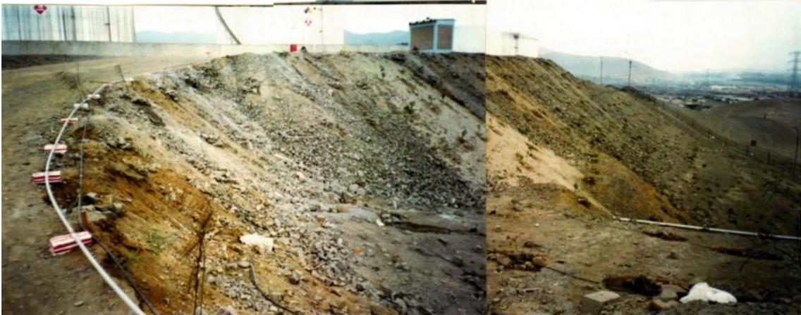
Foto 1: Corte en el que se puede apreciar la mezcla de relleno y litosol desértico.
