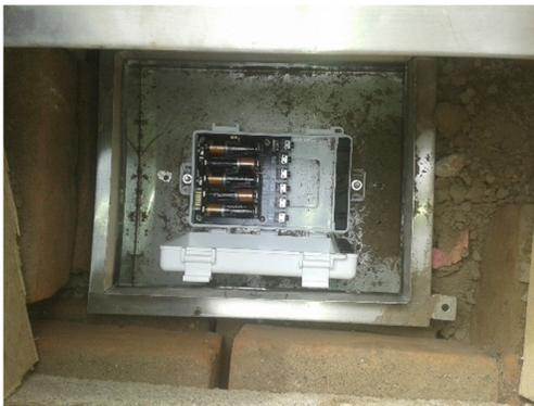
Colector de datos de los sensores de humedad del suelo
