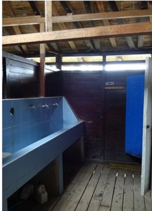
Figura 32: Fotografía de la vista interior de los servicios higiénicos comunes para el servicio de hospedaje del operador público.
