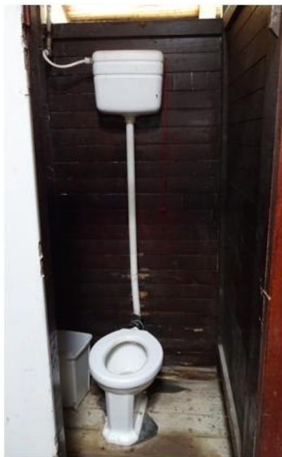
Figura 33: Fotografía de los servicios higiénicos comunes para el servicio de hospedaje del operador público.
