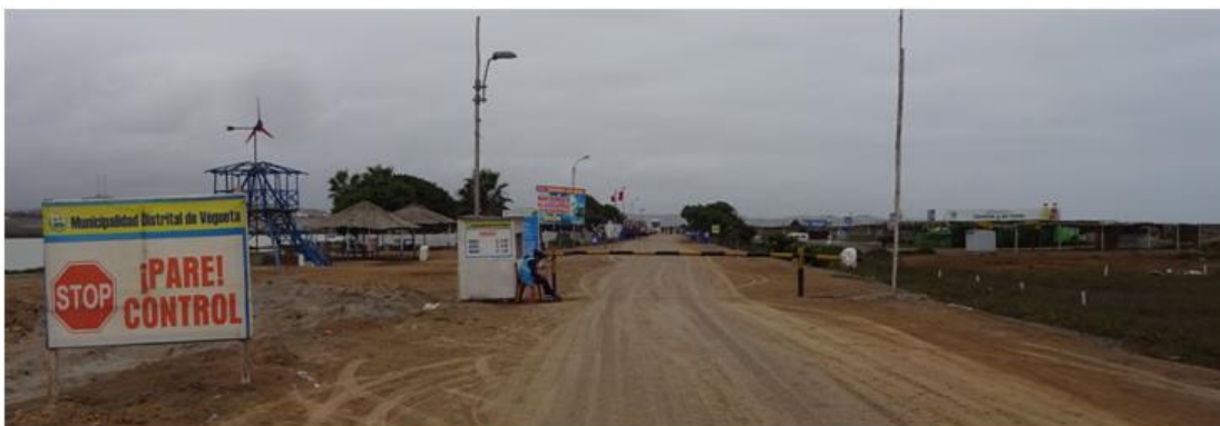
Figura 59: Fotografía de la garita de control, parte de la infraestructura del operador turístico público.
