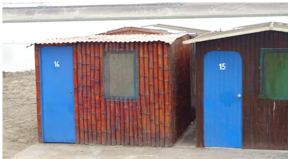
Figura 27: Fotografía de la vista exterior de las habitaciones construidas recientemente para el servicio de hospedaje del operador público.
