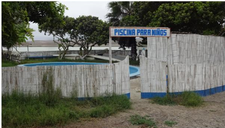
Figura 58: Fotografía de la piscina, parte de la infraestructura del operador turístico público.
