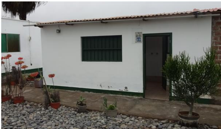
Figura 36: Fotografía de la vista exterior de los servicios higiénicos comunes para el servicio de hospedaje del operador privado.
