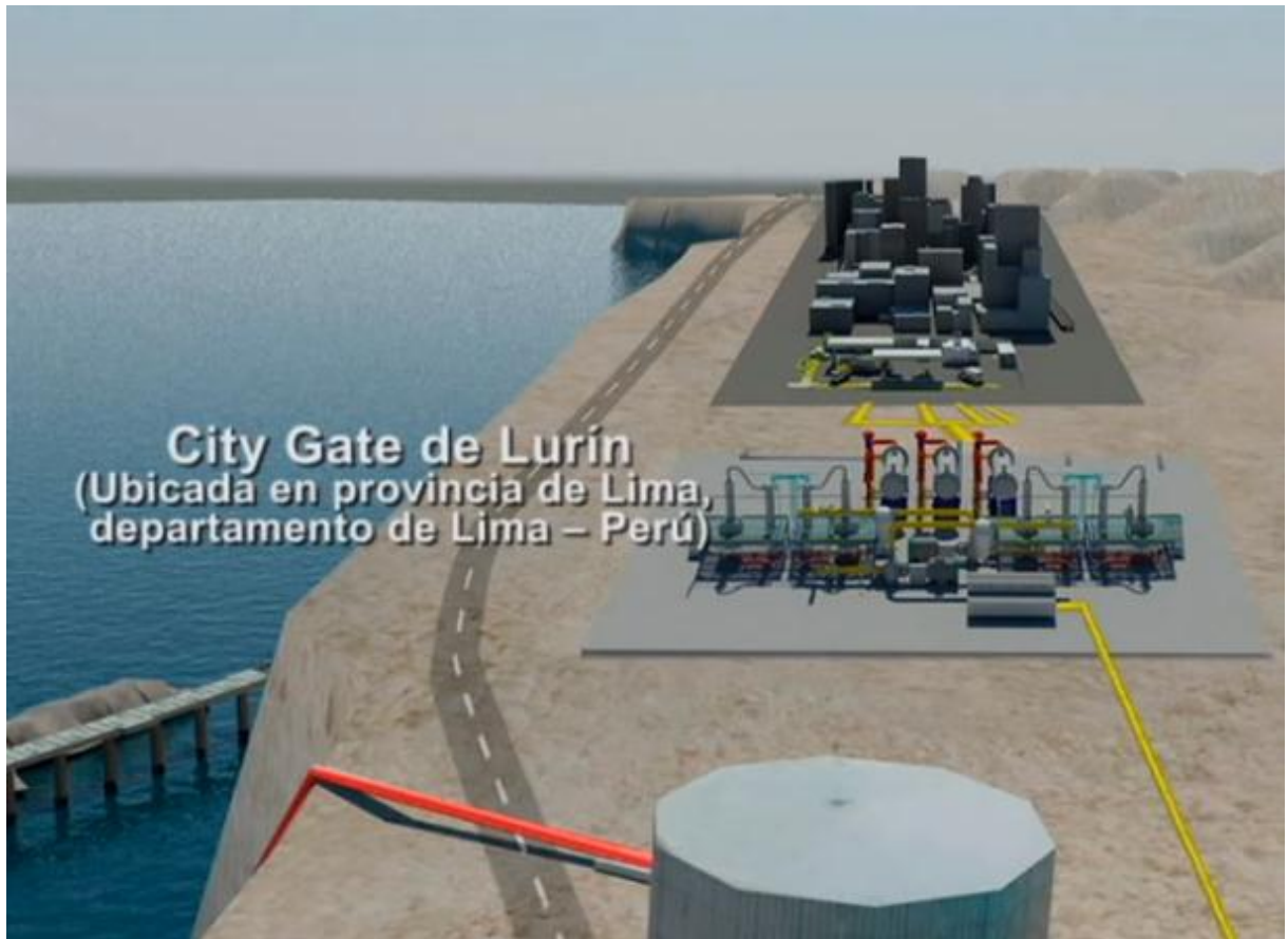
Figura 05.- City Gate de Lurín, estación de entrada de gas natural a la ciudad de Lima. Fuente: OSINERMIN, 2013.
