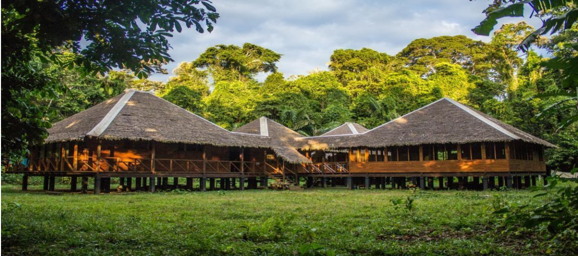
Figura 8: Instalaciones del albergue Refugio Romero
