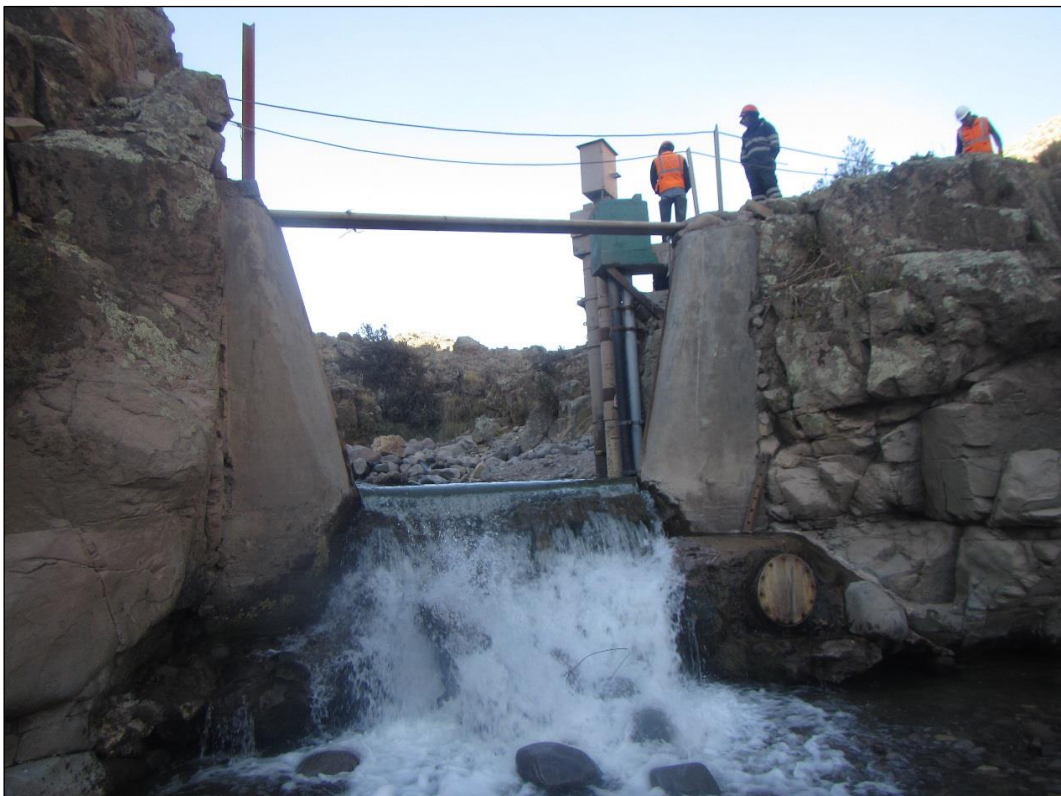
Foto 2: Estación hidrométrica Arundaya
