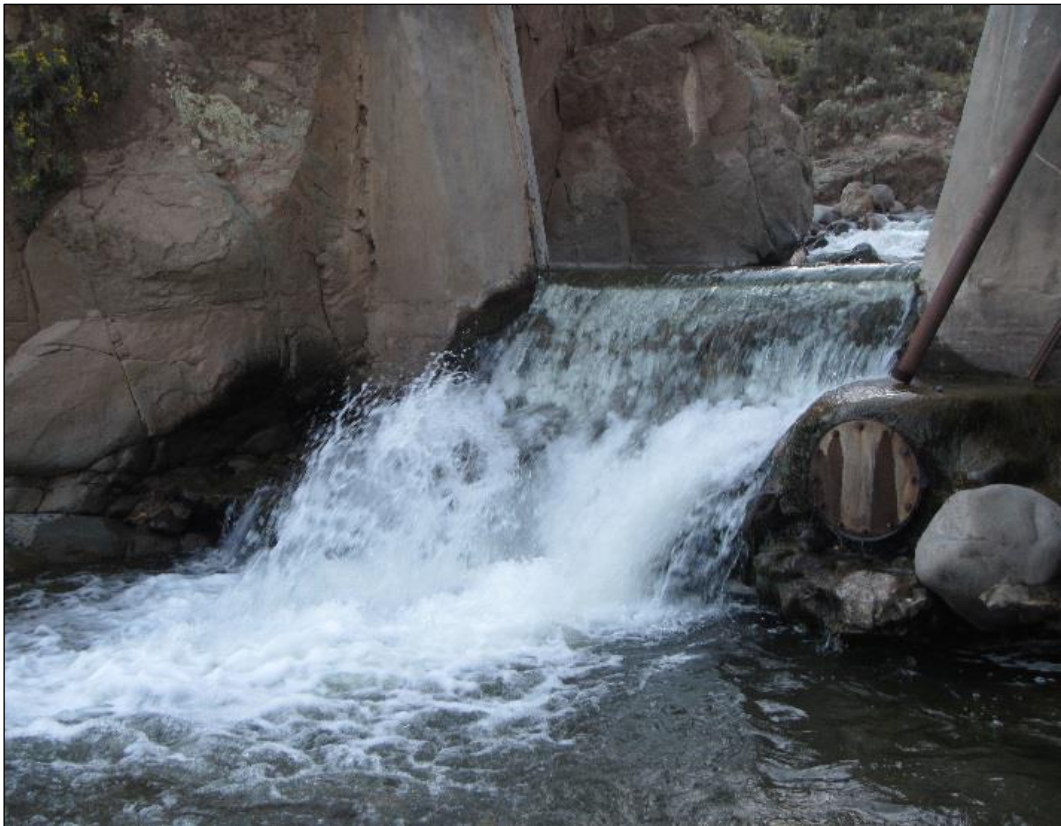
Foto 6: Vertedero de la estación hidrométrica Arundaya
