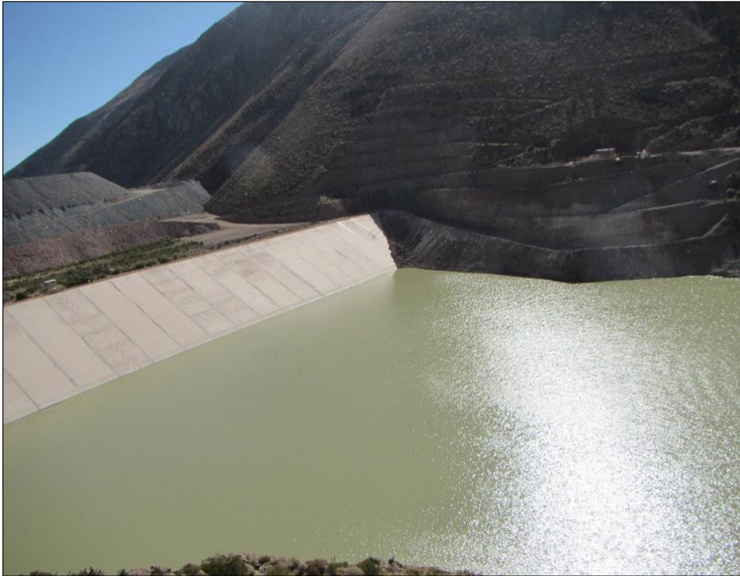
Foto 9: Dique Torata visto desde la margen izquierda
