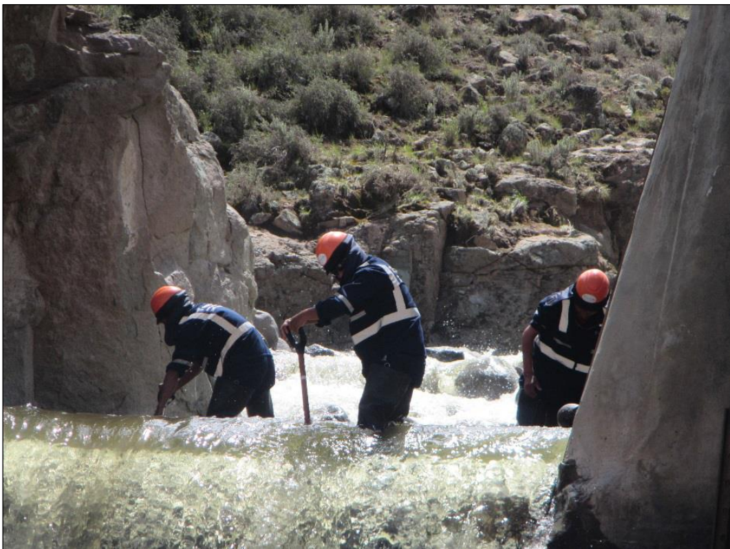
Foto 10: Trabajos de limpieza y mantenimiento en la estación hidrométrica Arundaya
