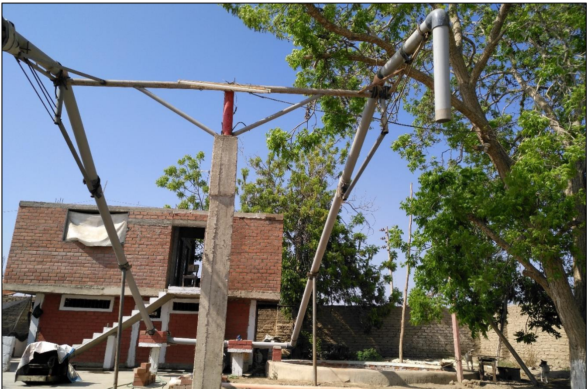
Fotografía 12: Pozo de extracción de agua subterránea
