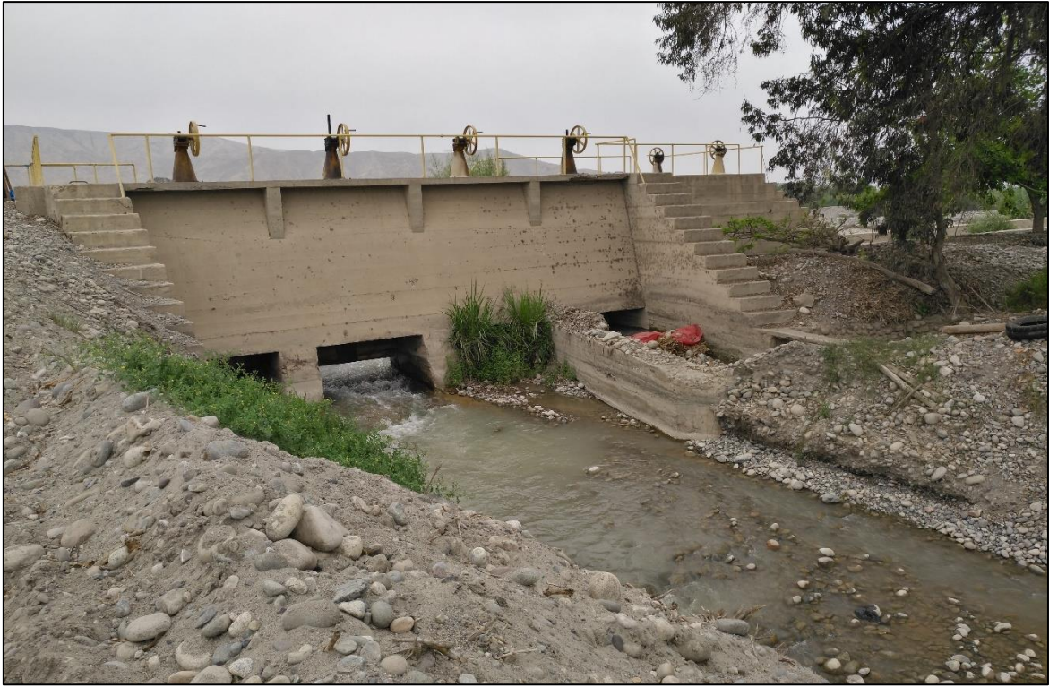
Fotografía 3: Bocatoma 'La Altura' en el río Matagente
