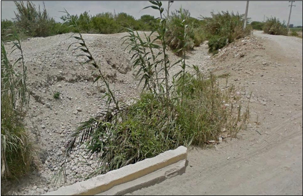
Fotografía 5: Canal no revestido en El Carmen
