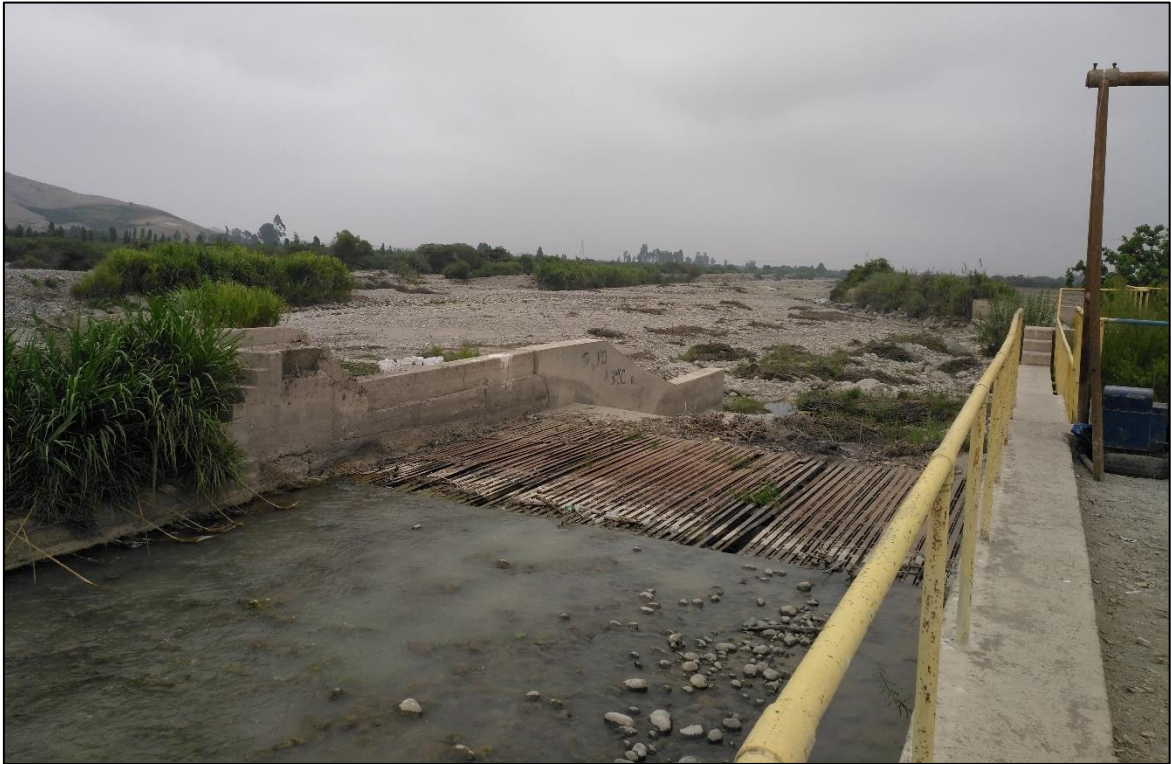
Fotografía 1: Vista hacia aguas abajo del río Matagente
