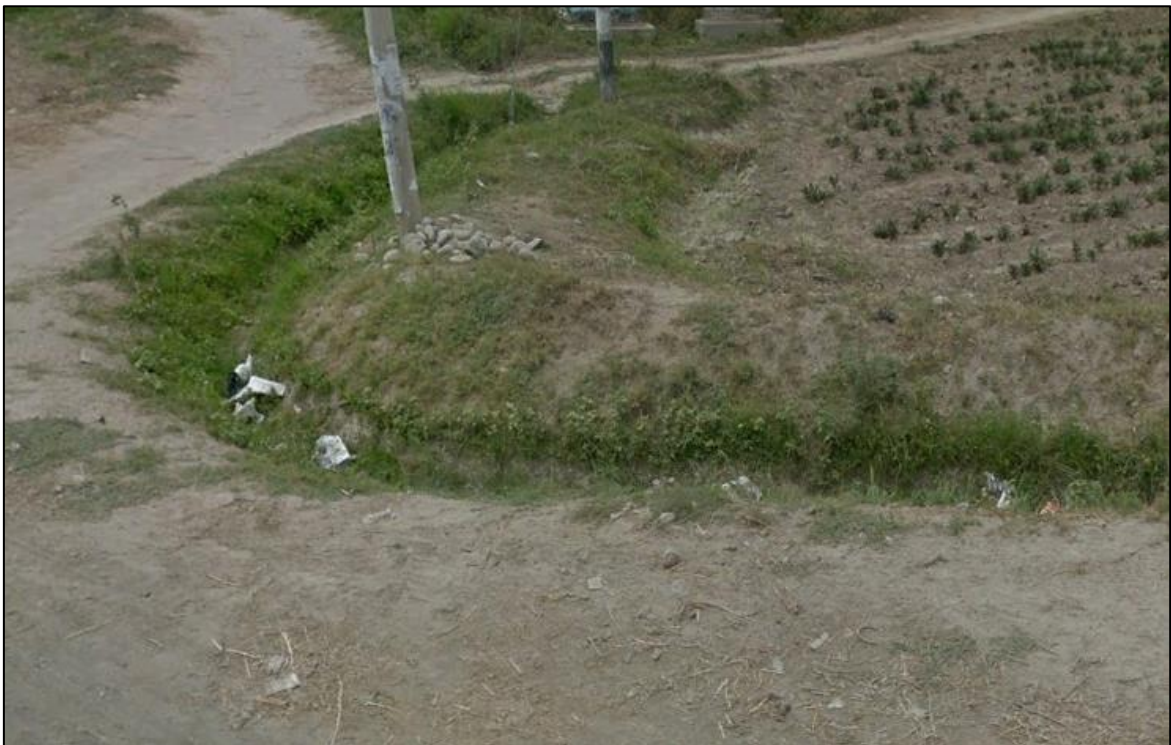
Fotografía 4: Canal no revestido en Chíncha Baja
