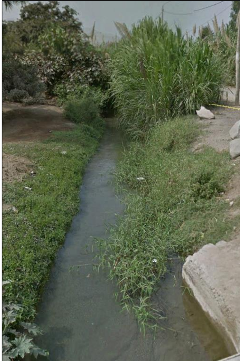
Fotografía 13: Canal no revestido en Chincha Baja
