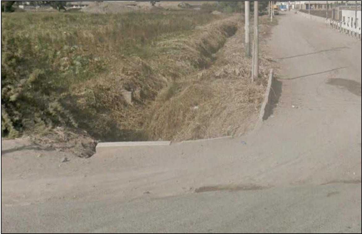
Fotografía 9: Canal no revestido en Alto Larán
