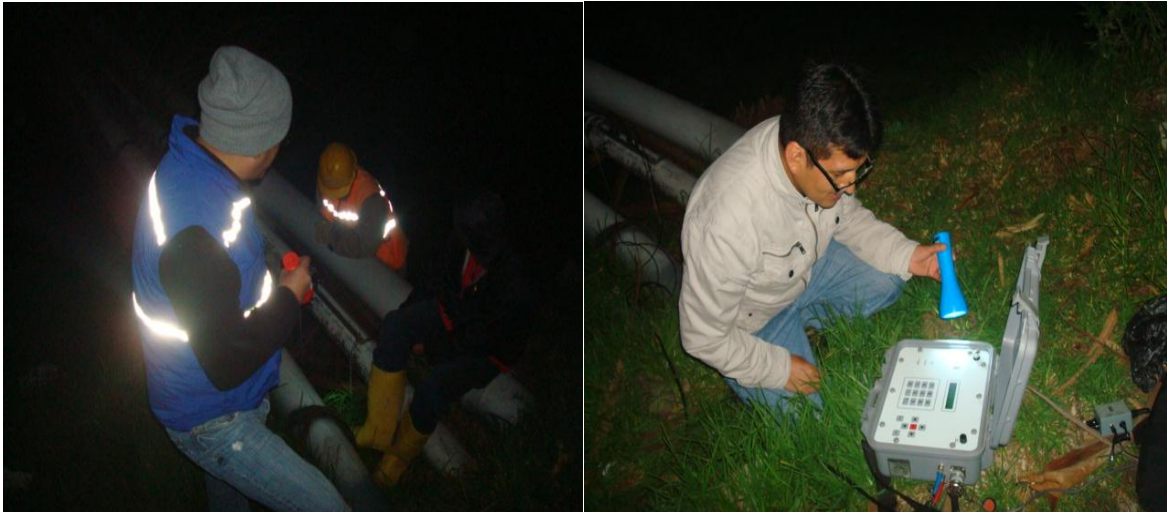
Figura 37: Estación 2 de medición de caudal ubicado en calle Vicente Rocafuerte y José Urbina (quebrada); Sondas del caudalímetro ultrasónico instalado en una tubería de PVC de 200 mm (imagen izquierda). Medición del caudal (imagen derecha)
