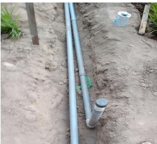
e) Instalación de purgas al finalizar líneas tercerías
