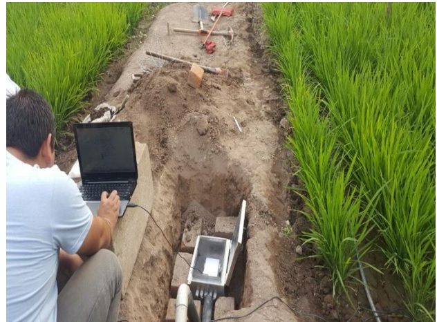
b) Instalación de data stored del FDR GS1 en campo.
