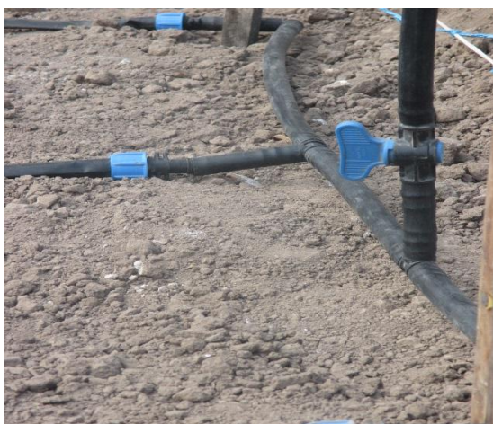
e) Instalación de válvula de PVC.
