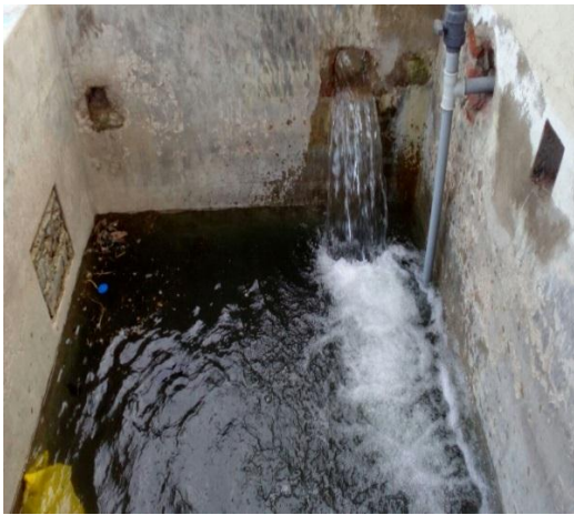
c) Reservorio y cambio de válvula check
