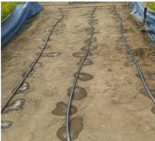
a) Instalación de cintas de riego al costado de las parcelas
