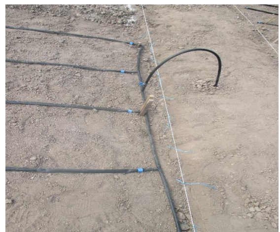
f) Conexión de los bigotes con ramal de cintas de riego.
