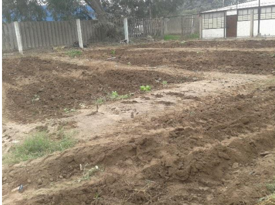
a) Remocion de terreno
