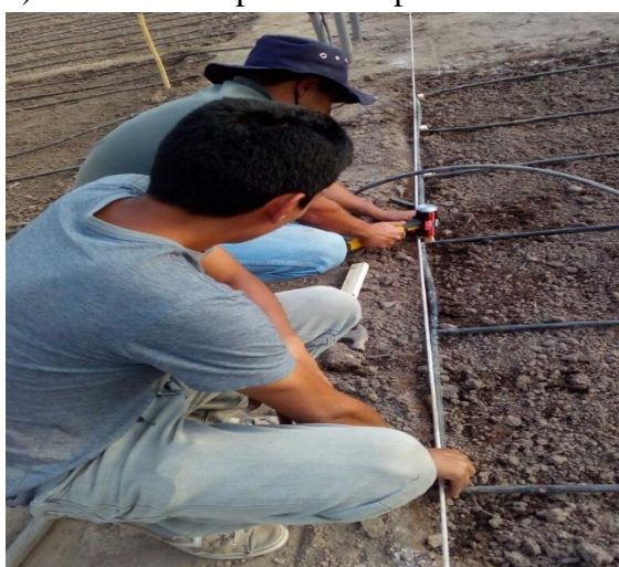
c) Instalación de laterales de riego
