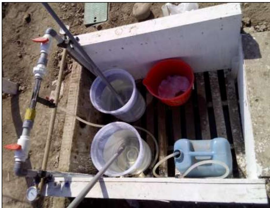
**Zona de inyección de fertilizantes mediante el inyector tipo venturi**
