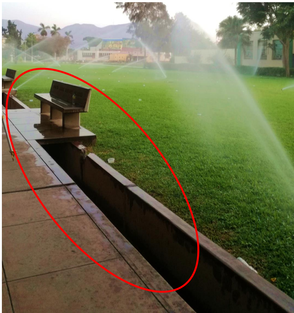
Figura 46: Segundo horario de riego de 3:00 a 3:30 p.m. válvulas 70-71-73
