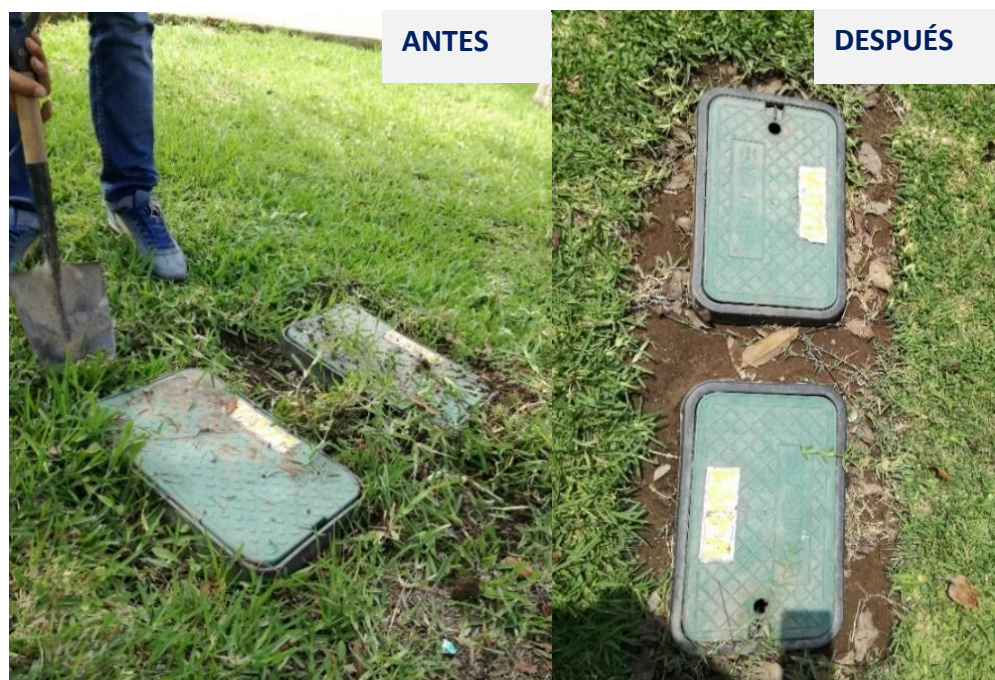
Figura 61: Limpieza de arco de riego
