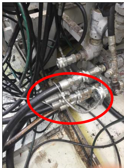
Implementación de sistemas anti latigazos en las mangueras para evitar fuga de aceite
