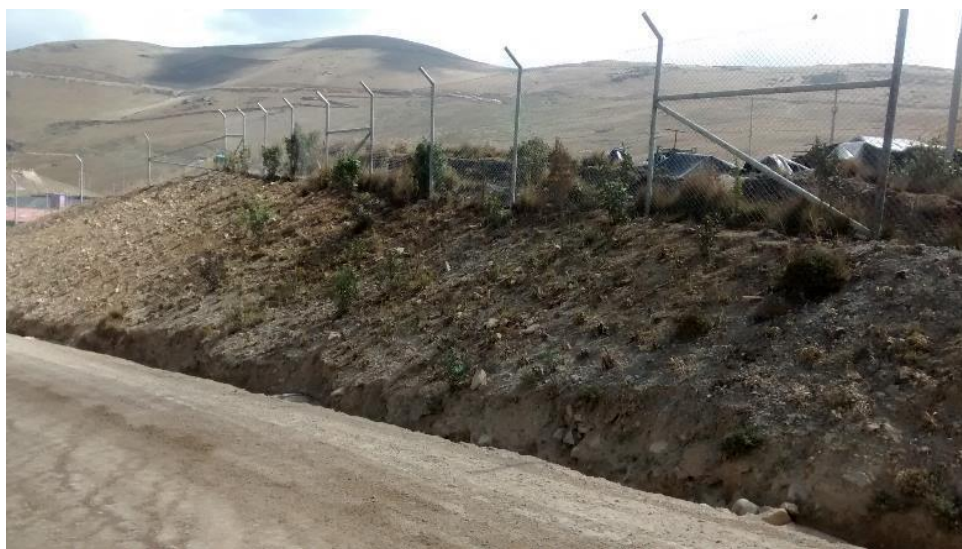
Figura 14: Talud con prueba de Cortadera recién instalada
