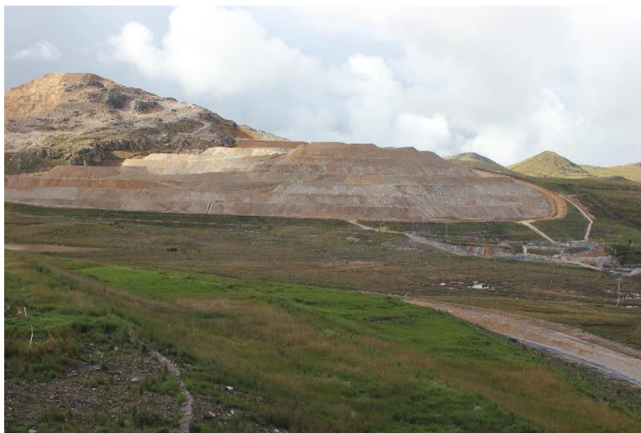
Figura 17: Depósito de Material Estéril
