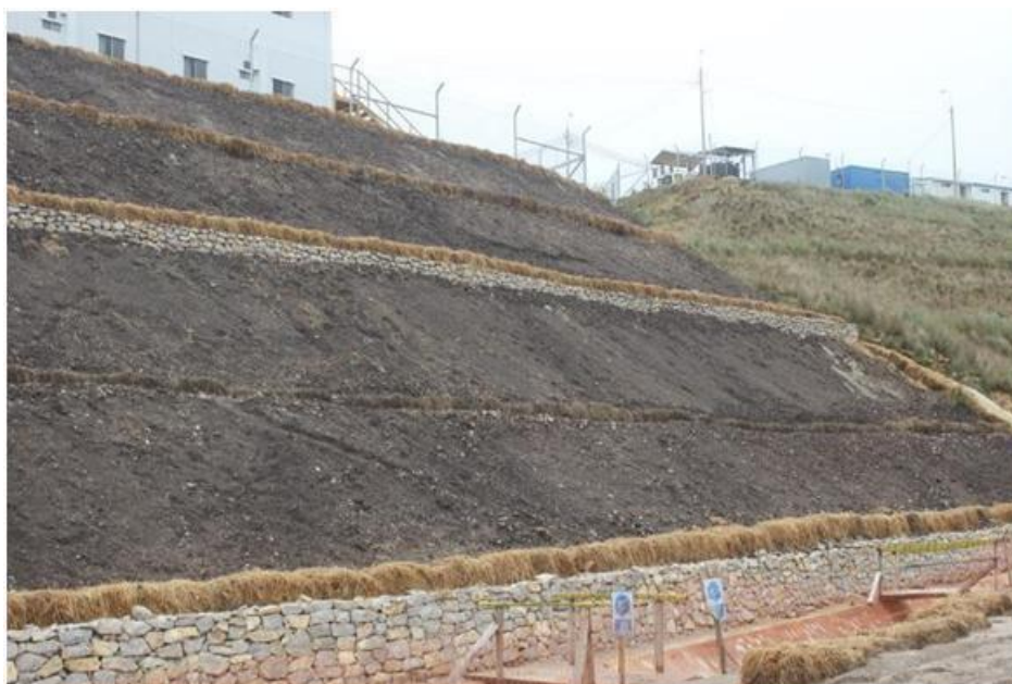
Figura 9: Trabajos complementarios en los taludes del área A29
