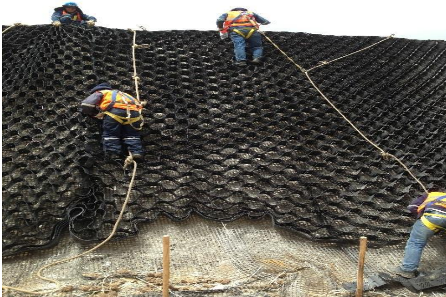
Figura 15: Colocación del sistema geoweb
