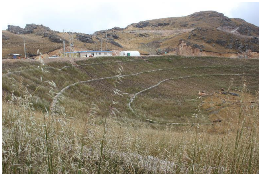
Figura 22: Áreas A6 y A46 luego de los trabajos de remediación
