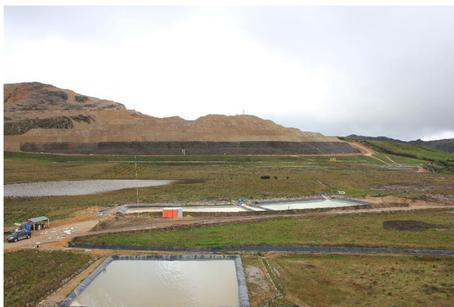
Figura 25: Vista panorámica del cierre del Depósito de Material Estéril
