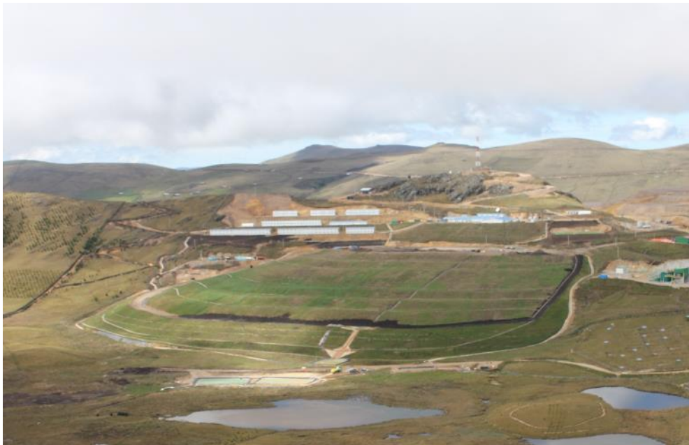
Figura 24: Vista panorámica del cierre del Depósito de Material Inadecuado
